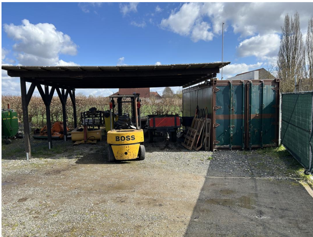
Anlage 5.1: Bild 1 Ansicht Container mit Unterstand
