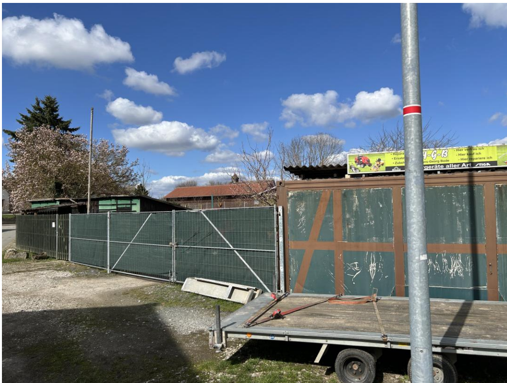
Anlage 5.4: Bild 4 Straßenseitige Einfriedung und Tor mit Bauzaunelementen
