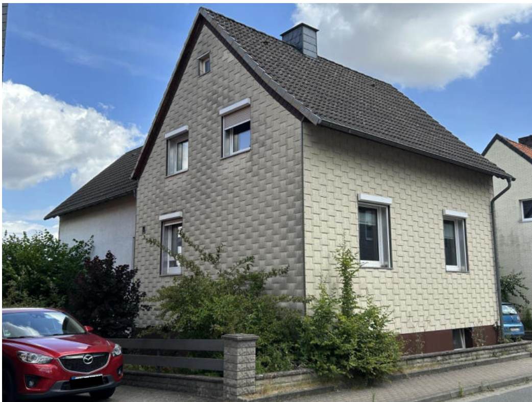
Anlage 5.2: Bild 2 Ansicht von Nordosten
