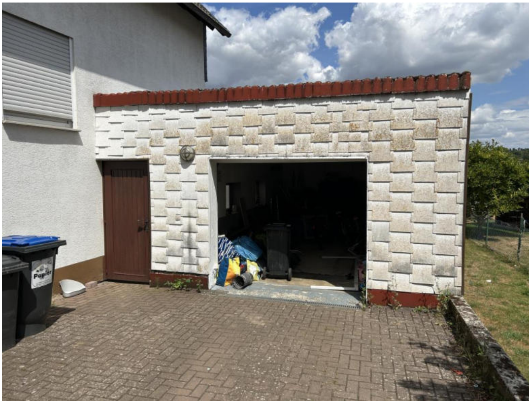
Anlage 5.3: Bild 3 Ansicht von Südwesten
