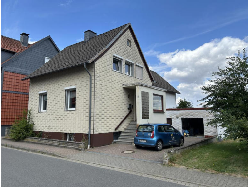
Anlage 5.1: Bild 1 Ansicht von Nordwesten
