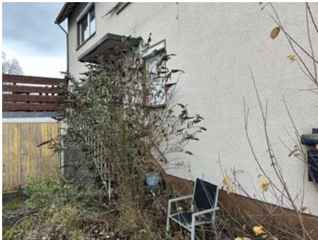
Anlage 5.6: Bild 6 Hauseingangsbereich mit Treppenanlage
