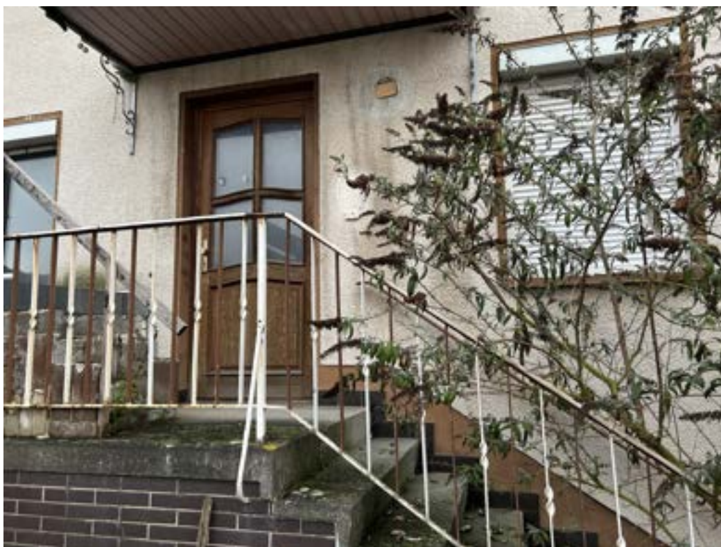
Anlage 5.7: Bild 7 Haustür
