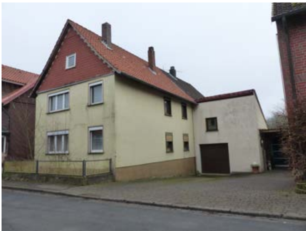
Bild 2: lfd. Nr. 3 - Ostansicht
