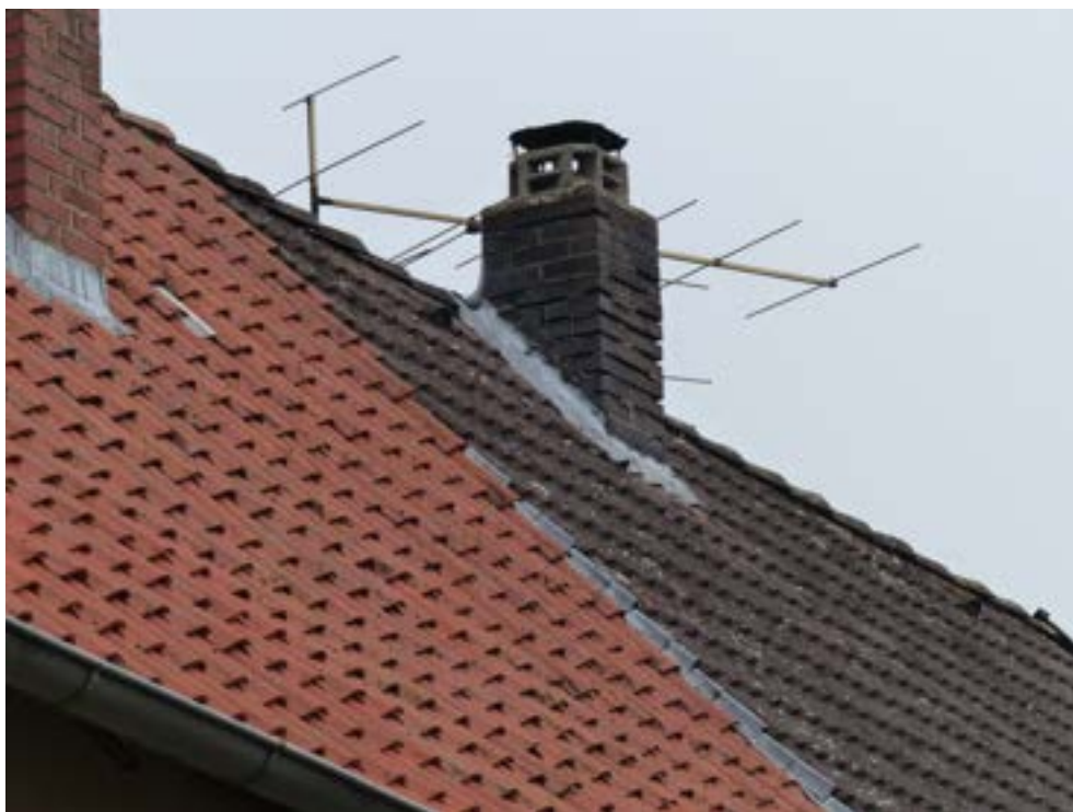
Bild 6: Mangelhafter Schornsteinkopf
