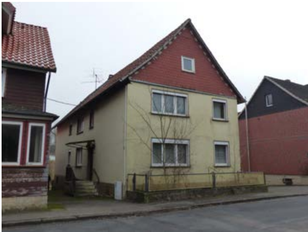
Bild 1: lfd. Nr. 3 - Nordansicht
