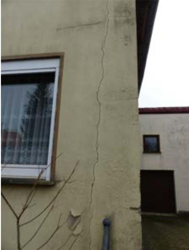
Bild 7: Riss im Mauerwerk
