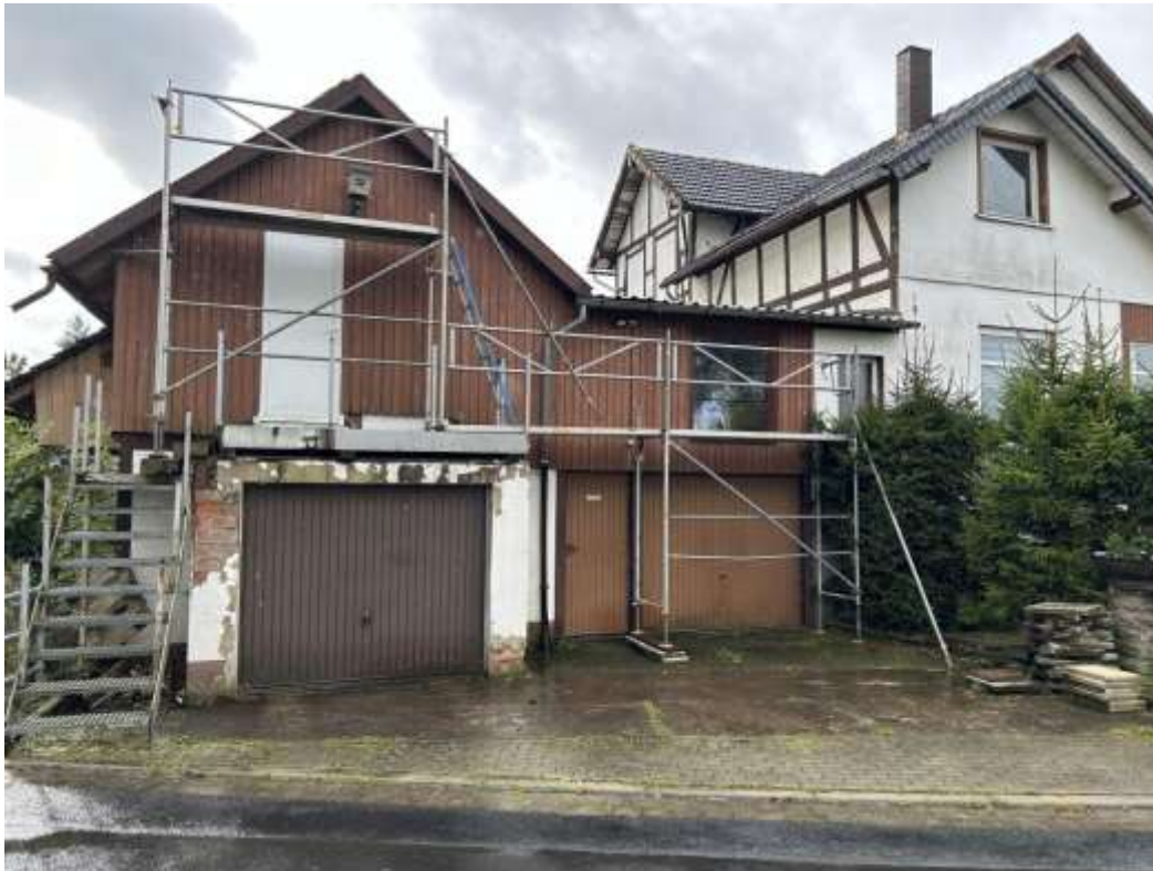
14: 14 Detail Zugang Partyraum ohne adäquate Absturzsicherung, Geländer, etc.
