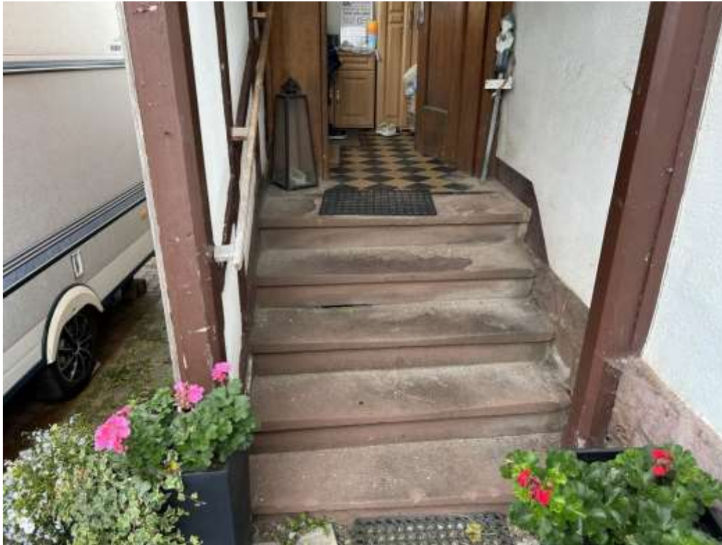
Anlage 5.5: Bild 5 Hauseingangsbereich
