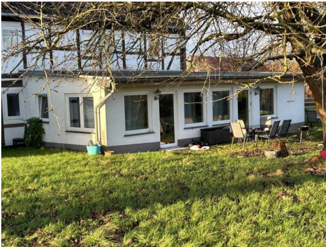
Anlage 5.3: Bild 3 Ansicht von Südosten auf den eingeschossigen Anbau
