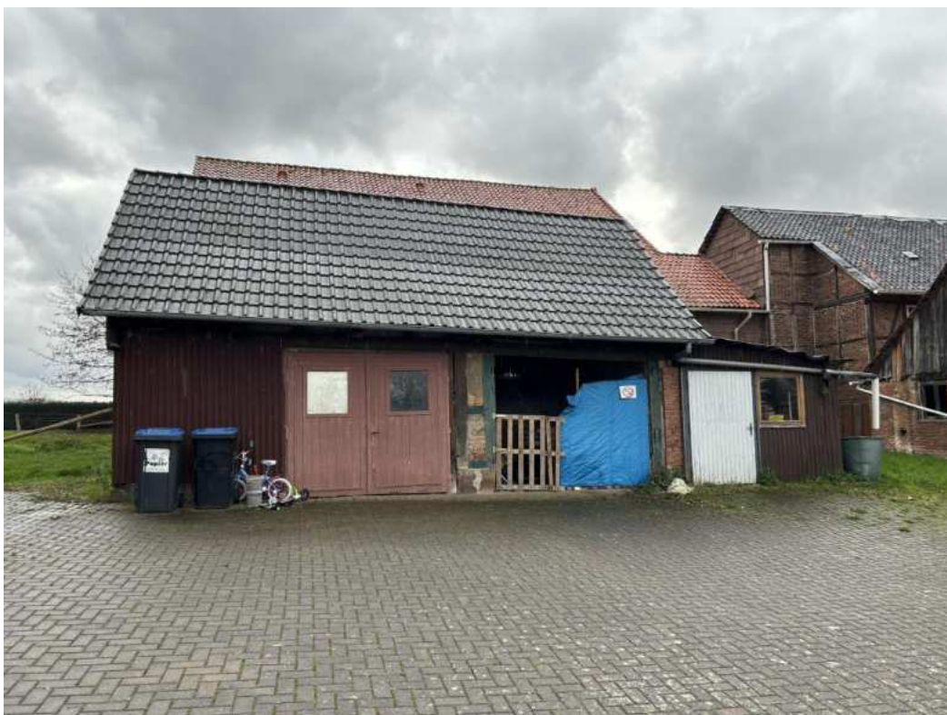
Anlage 5.4: Bild 4 Nebengebäude 1 Garagen- und Abstellgebäude
