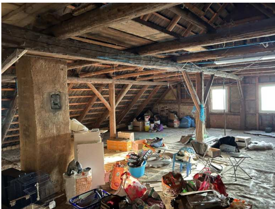
Anlage 5.16: Bild 16 Dachboden ohne Dämmung oberste Geschossdecke
