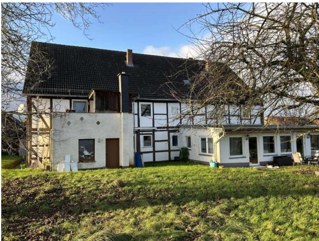
Anlage 5.2: Bild 2 Ansicht von Südosten
