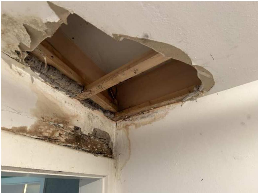
**Anlage 5.14:** Bild 14 Bauteilöffnung in Wohnung 1, Schäden an Unterdecke und Anstrich
