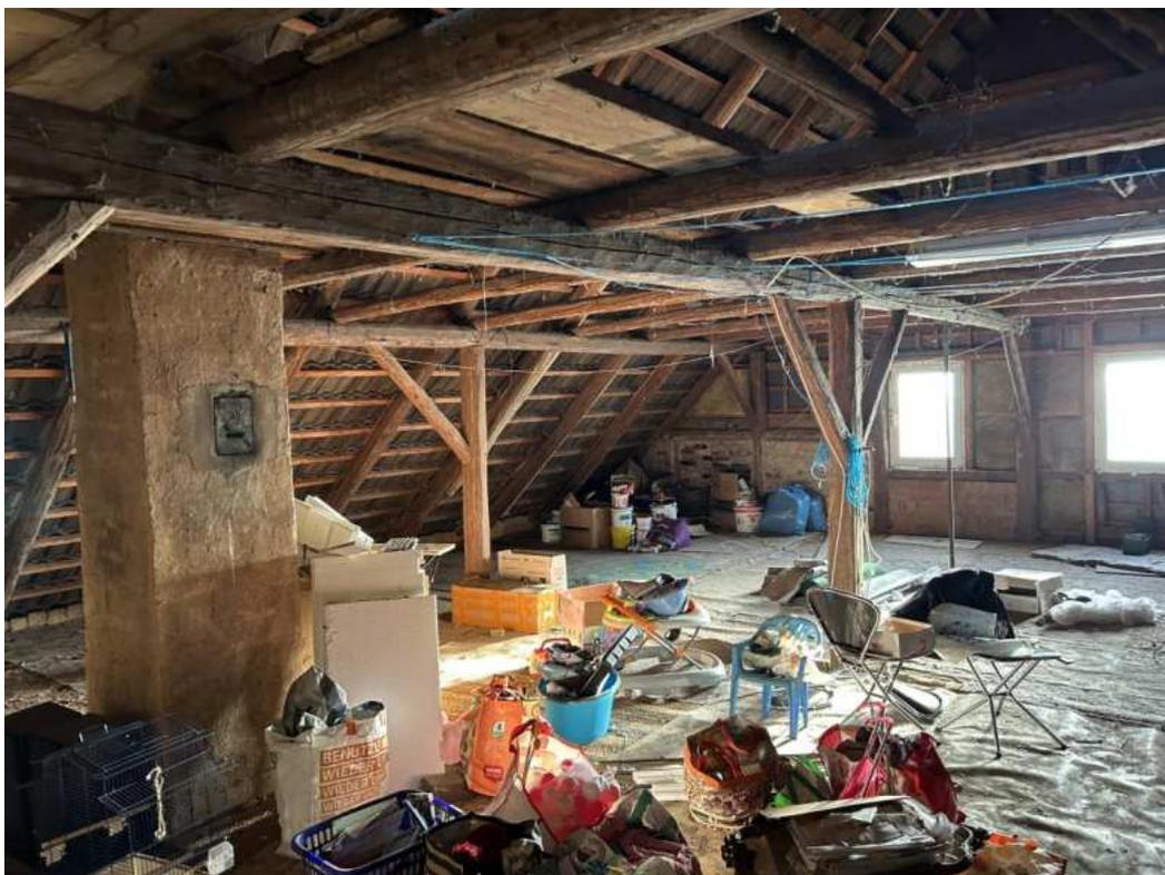
Anlage 5.16: Bild 16 Dachboden ohne Dämmung oberste Geschossdecke
