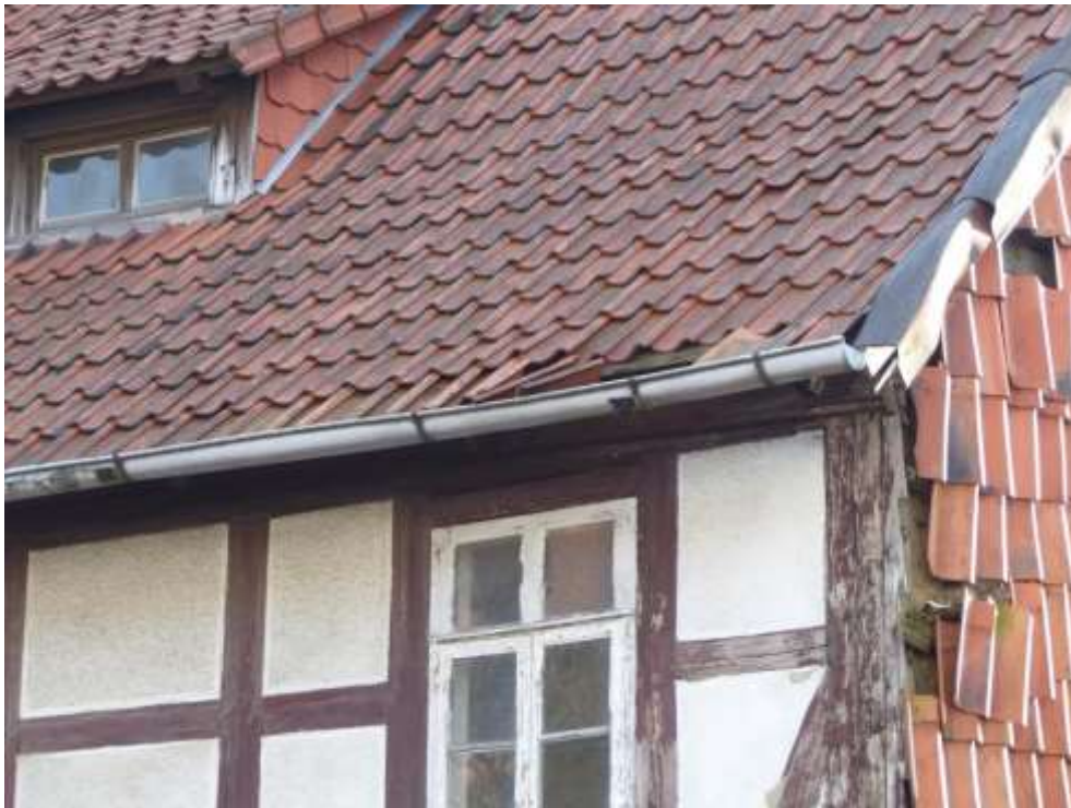
Bild 11: Mangelhafte Eindeckung
