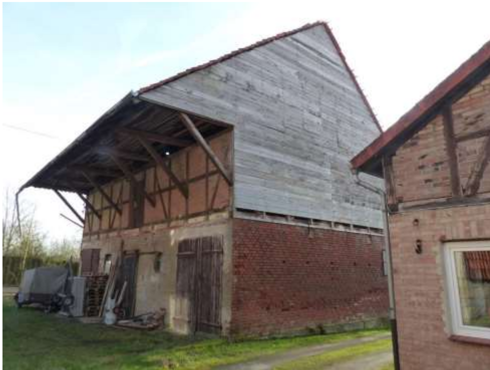
Bild 9: Landwirtschaftliches Betriebsgebäude - Nordwestansicht
