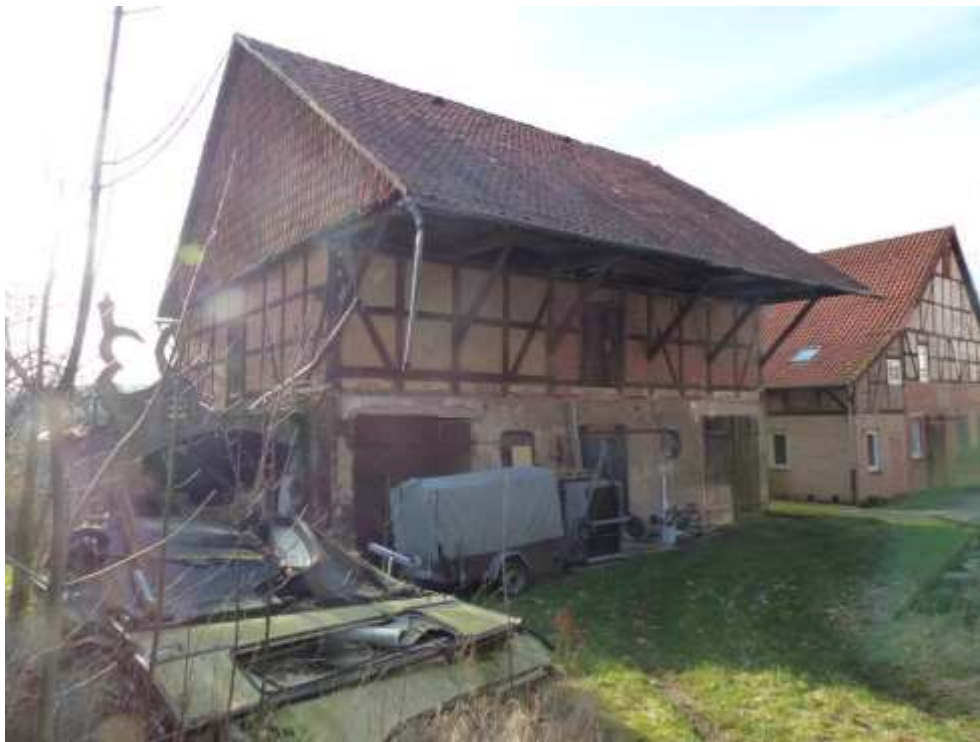
Bild 7: Landwirtschaftliches Betriebsgebäude - Nordostansicht
