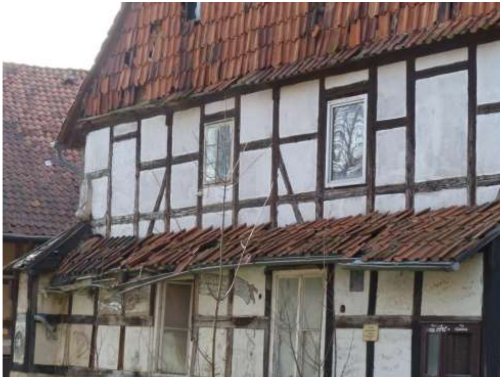
Bild 14: Mangelhafte Eindeckung
