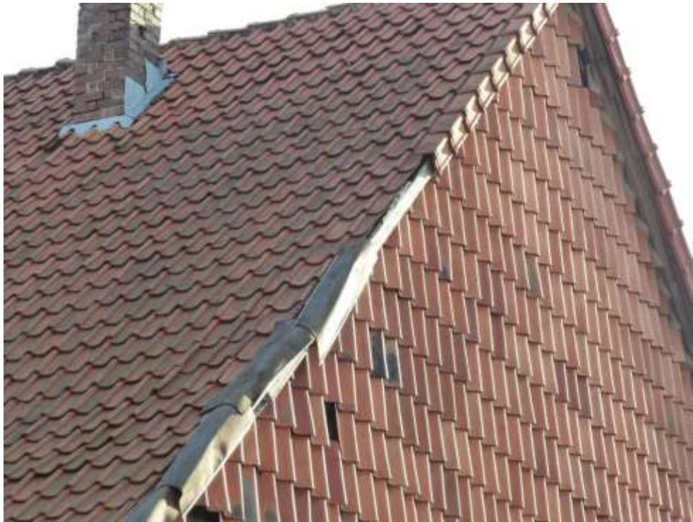
Bild 12: Mangelhafter Ortgang
