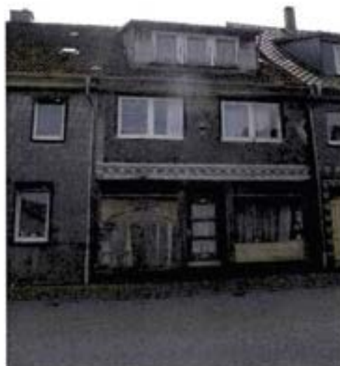
Bild 2: Ansicht des Bewertungsobjekts aus nördlicher Richtung von der Straße aus
