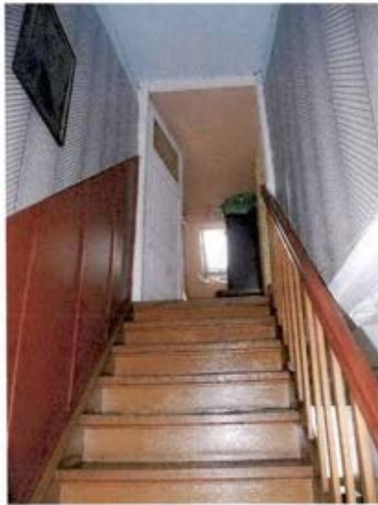
Bild 19: Ansicht Holztreppe vom OG zum DG des Bewertungsobjekts
