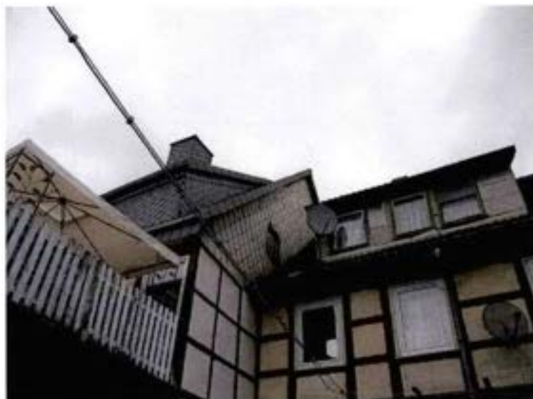
Bild 4: Ansicht des Bewertungsobjekts aus südöstlicher Richtung mit dem Nachbargrundstück Bahnhofstraße 34
