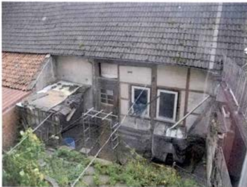
Bild 23: Ansicht Nebengebäude (nur der mittlere Teil) vom Dachgeschoss des Bewertungsobjekts aus
