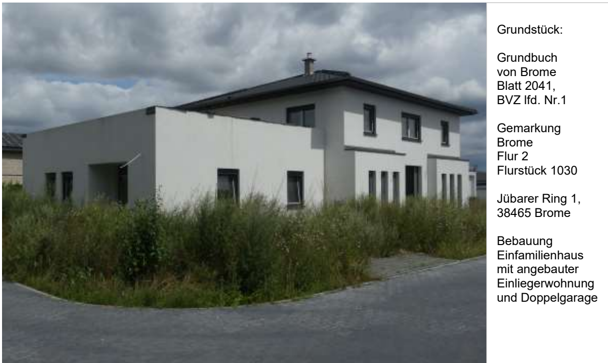
Südostansicht. Blick von der Straße auf das Wohngebäude und die angebaute Einliegerwohnung
