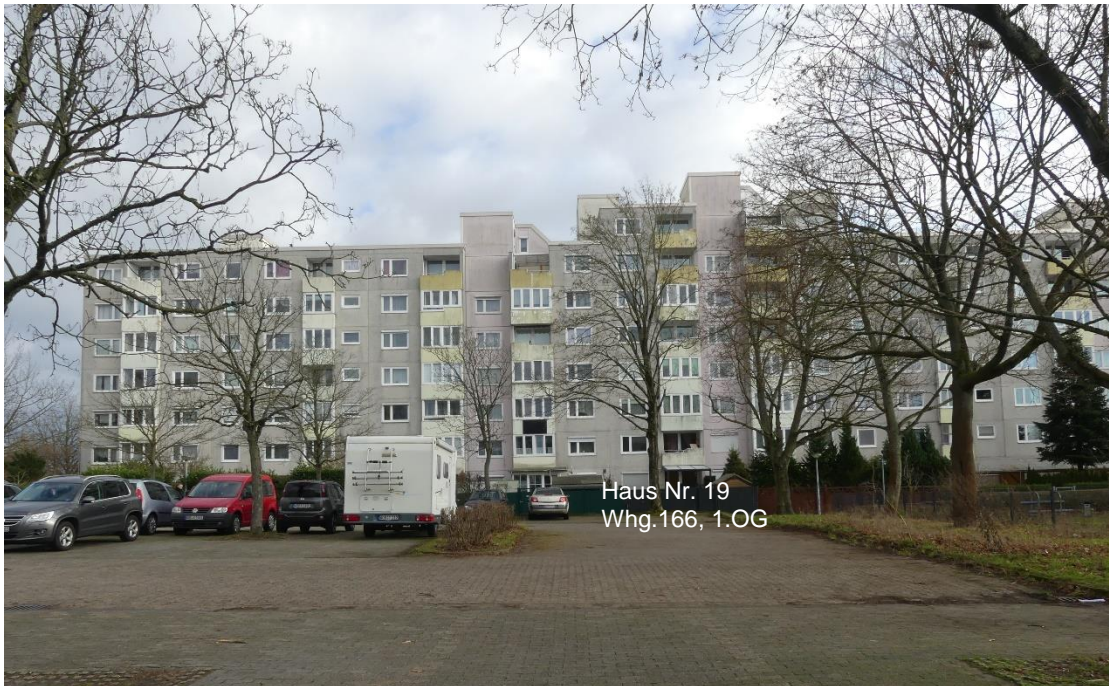
Westansicht Teilübersicht Halberstädter Straße 21,19,17,15 Wohnung Nr.166 im 1. OG, Halberstädter Straße 19
