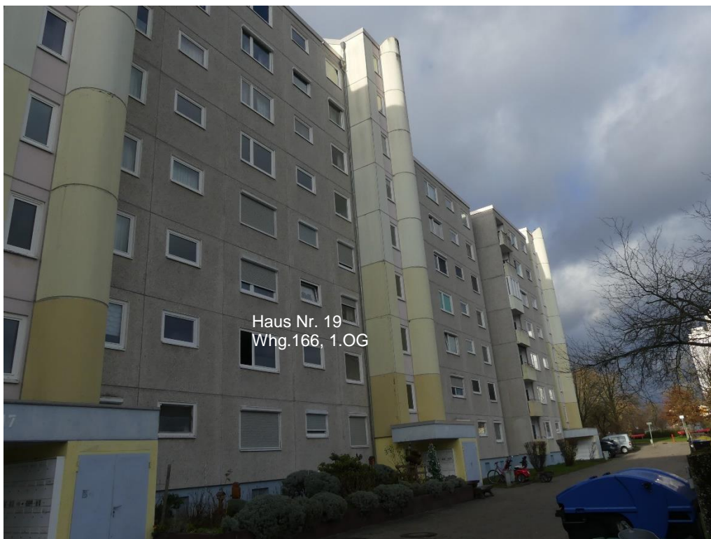
Wohnung Nr.166 im 1. OG, Halberstädter Straße 19, Ostansicht
