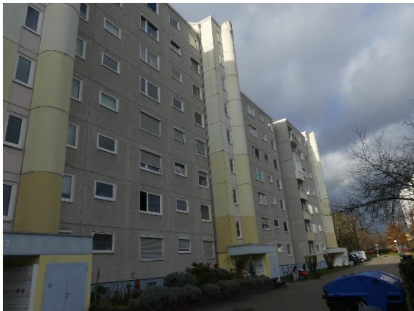
Wohnung Nr.166 im 1. OG, Halberstädter Straße 19
