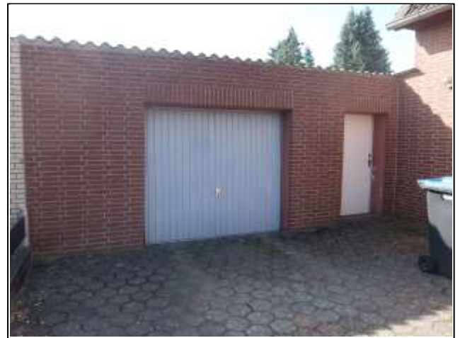
Ansicht Garage von Norden
