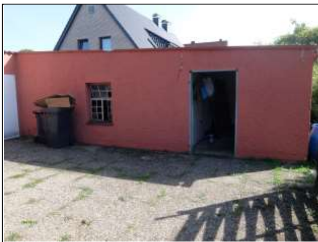
Ansicht Garage von Westen
