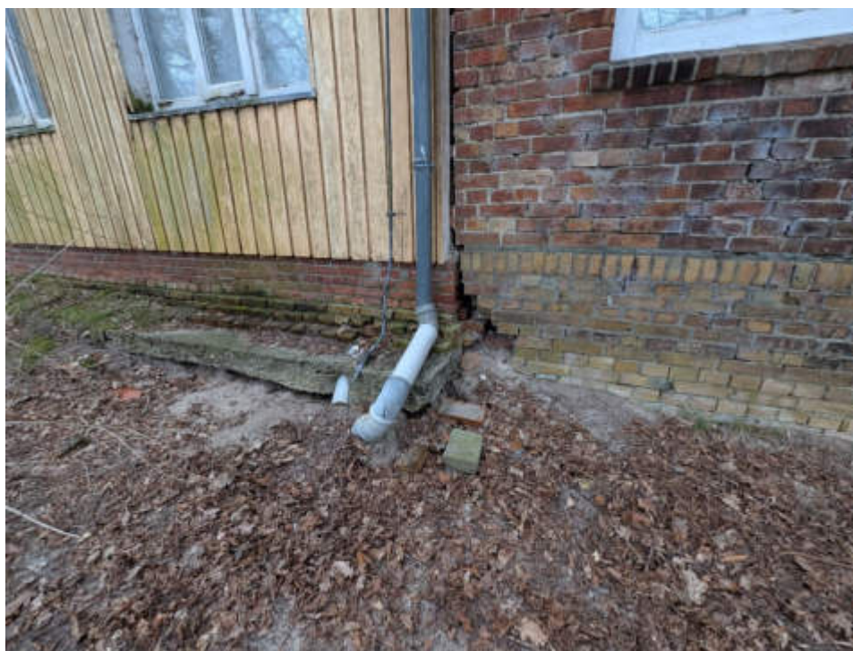
Bild 6: beschädigter Sockel
