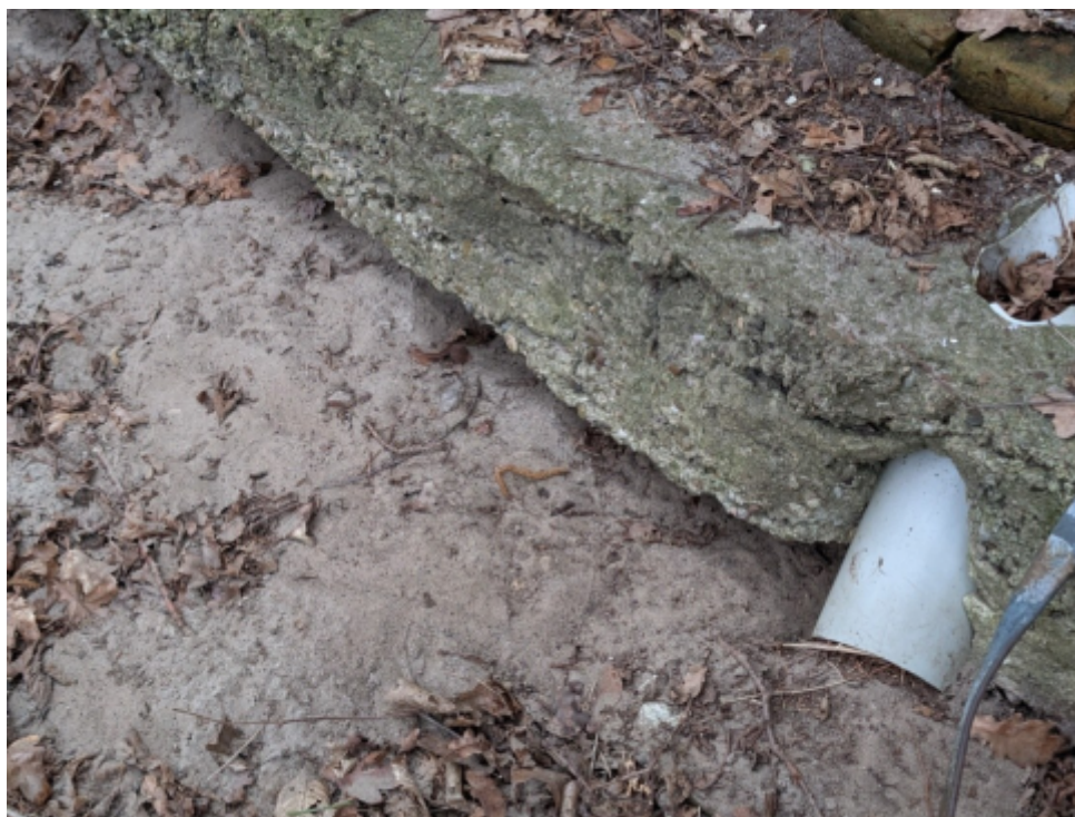
Bild 6: beschädigter Sockel
