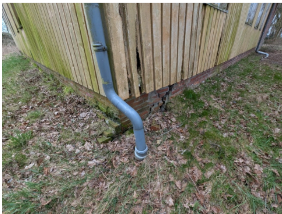
Bild 4: beschädigter Sockel
