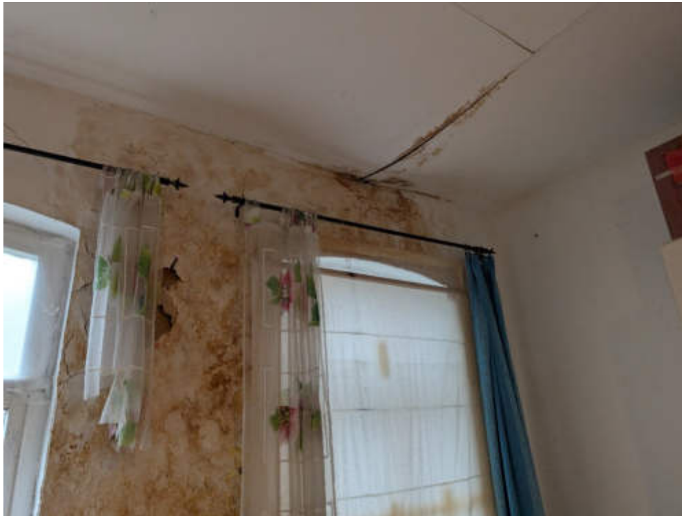
Bild 13: durchfeuchtete Außenwand
