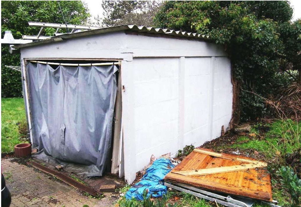
Bild 7: Garage (1960) aus südöstlicher Richtung
