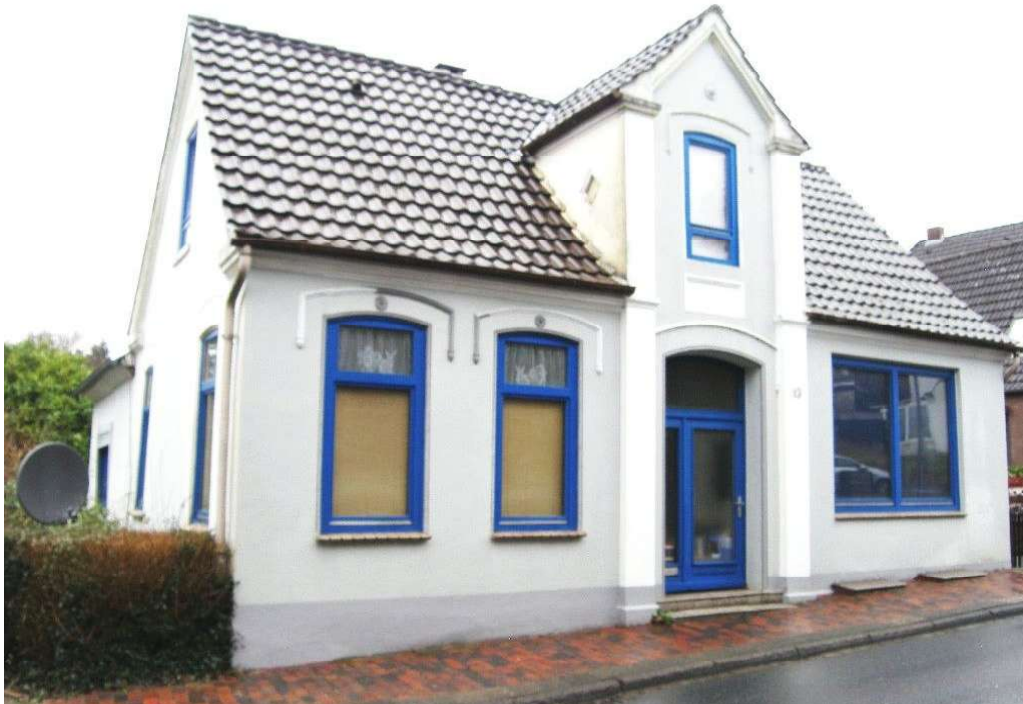
Bild 2: Straßenansicht des Wohnhauses aus südwestlicher Richtung
