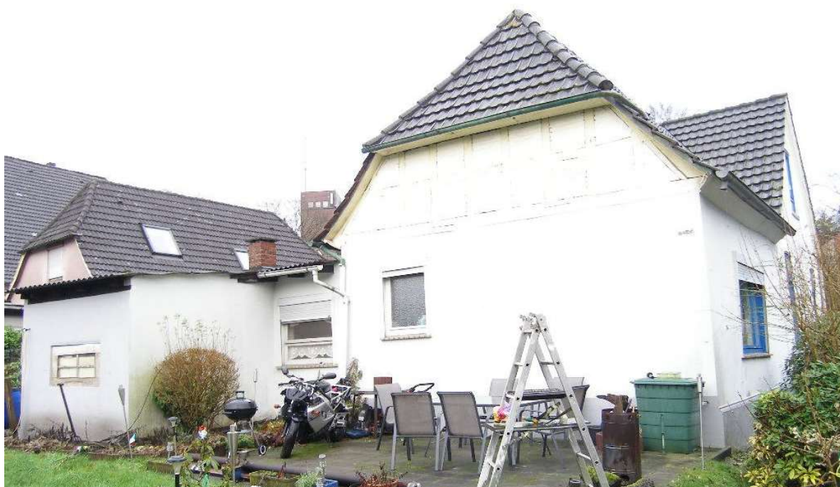
Bild 6: Rückansicht des Bewertungsobjekts aus nordwestlicher Richtung
