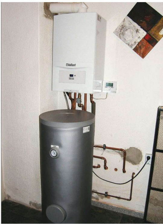
Bild 4: Gas-Heizung, 2022, WW-Speicher
