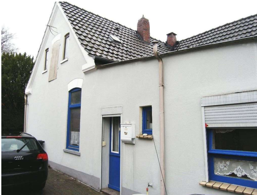
Bild 3: Seitenansicht des Wohnhauses aus nordöstlicher Richtung
