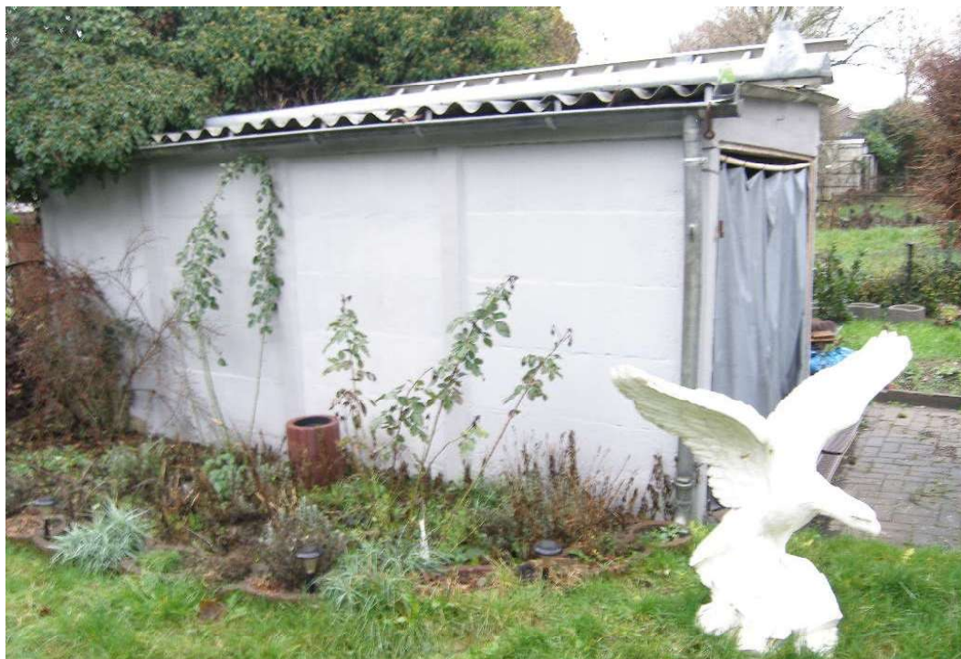
Bild 8: Garage (1960) aus westlicher Richtung
