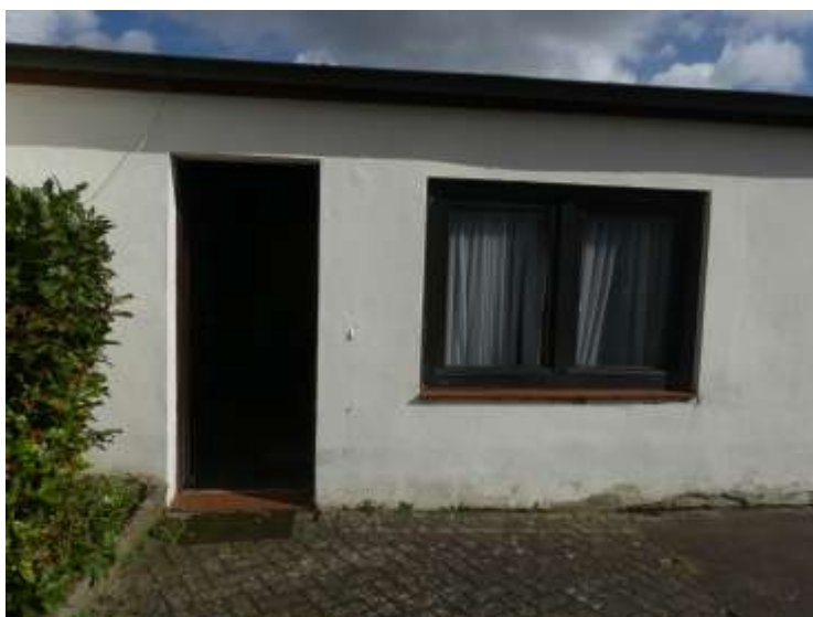
Nebengebäude, Lager- bzw. Partyraum
