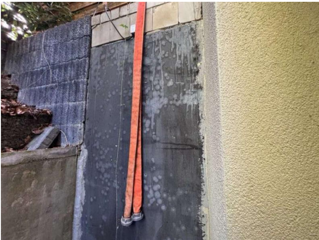
Bild 48 - Außenwand Keller, Abdichtung, Leitungsführung
