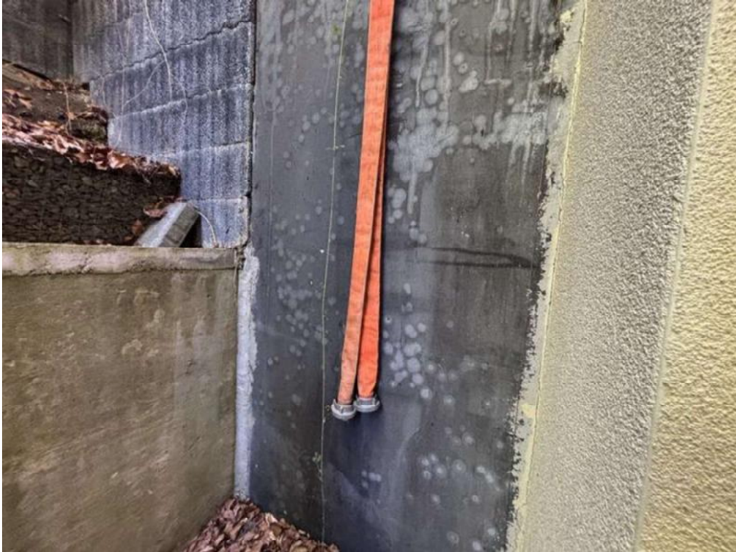
Bild 49 - Kelleraußenwand, Feuchtigkeitsspuren
