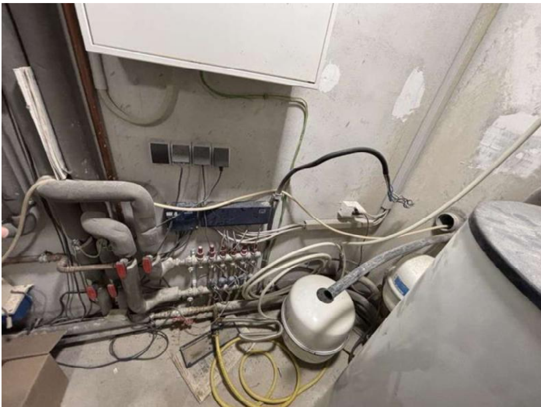
Bild 28 - Heizkreisverteiler, Rohrleitungen
