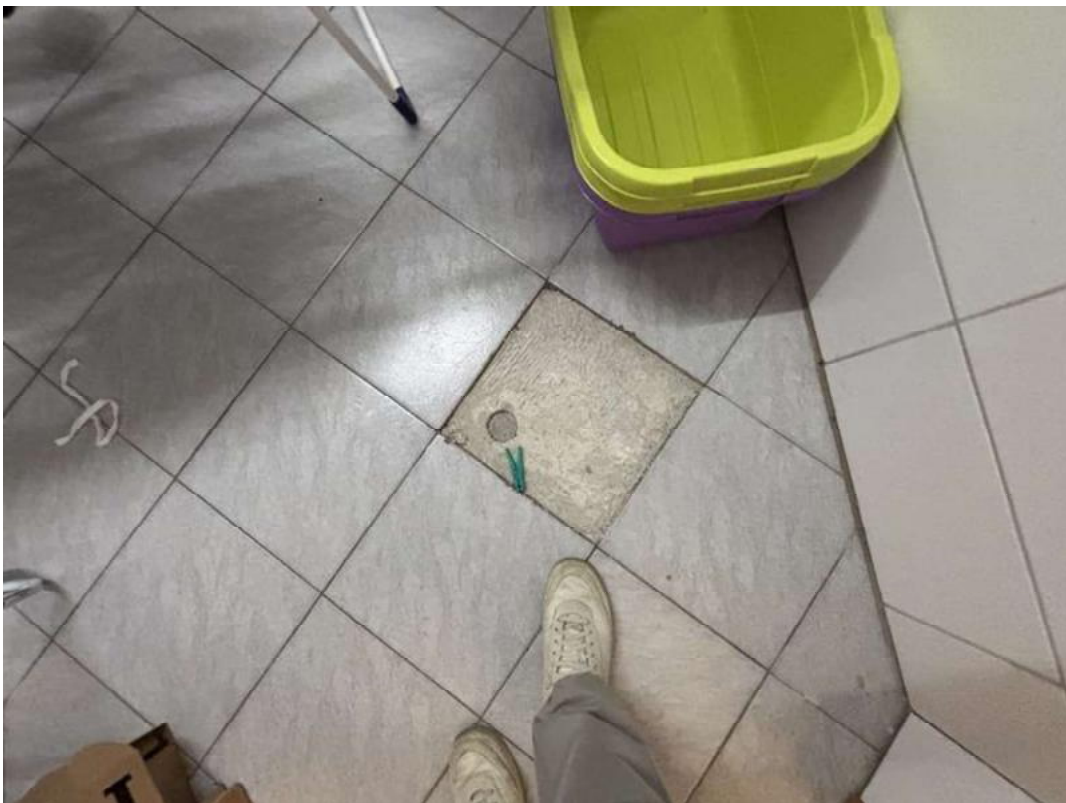
Bild 36 - Revisionsöffnung Boden, Fliesenbelag
