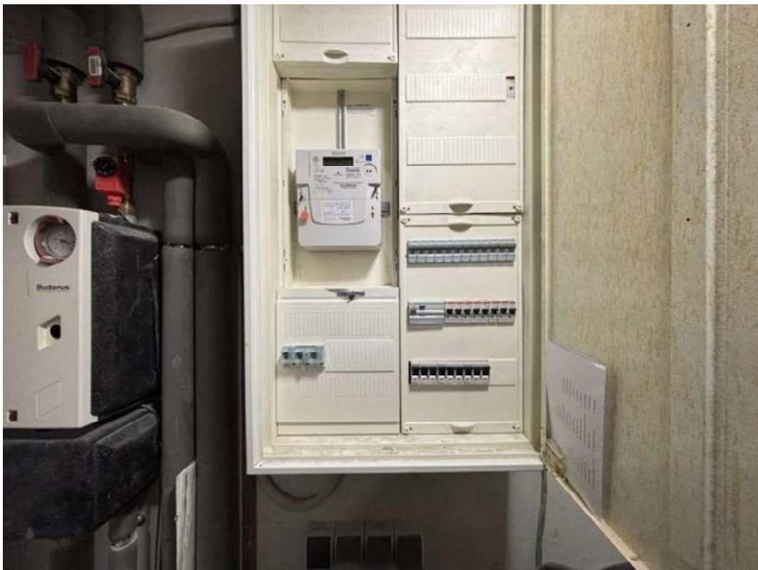
Bild 38 - Zählerschrank
