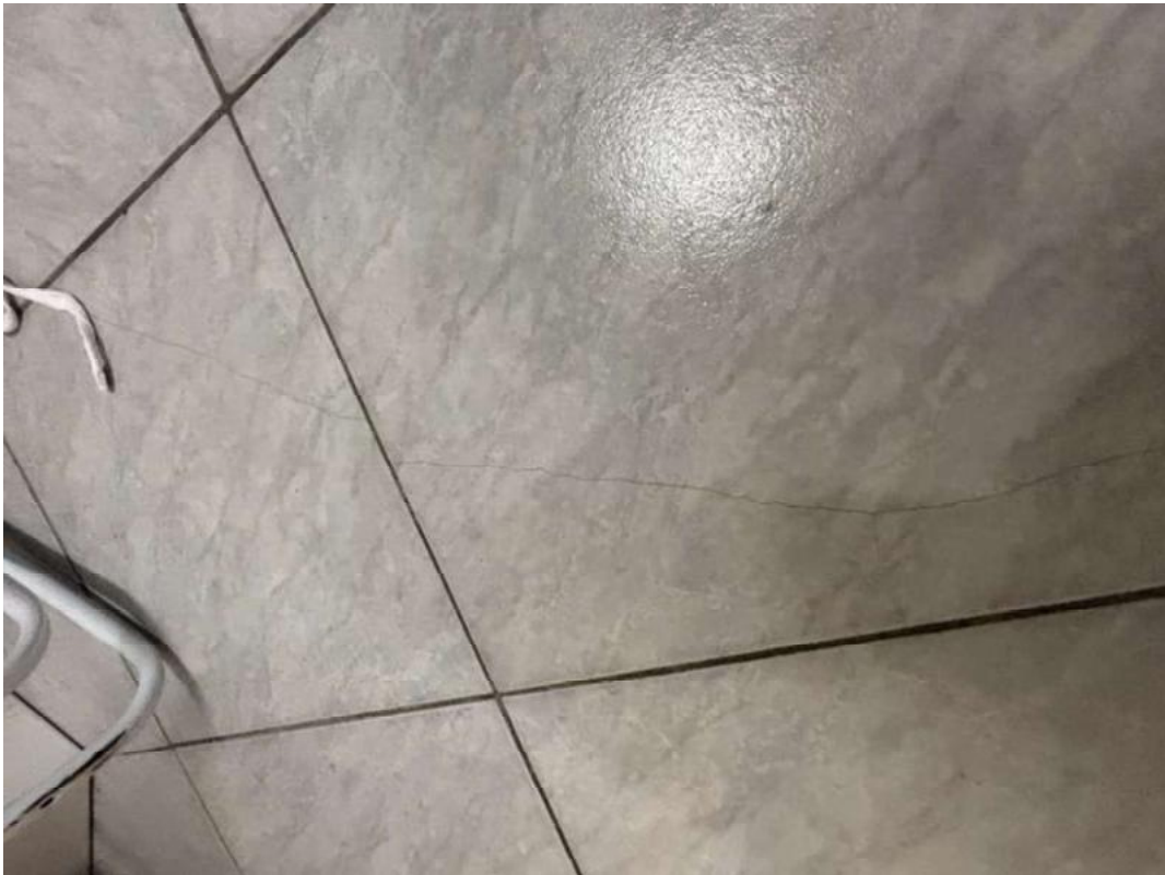
Bild 35 - Riss Fliesenboden
