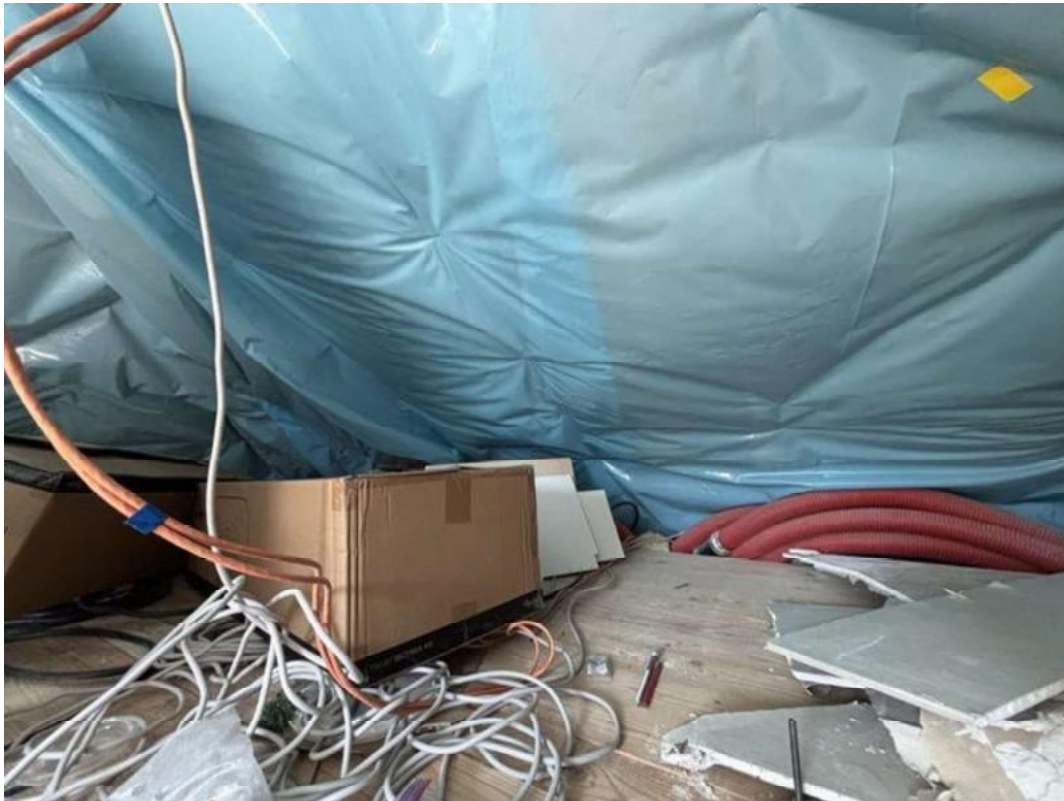
Bild 21 - Dachboden, Dampfsperre, Installationen
