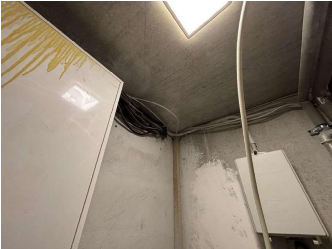
Bild 29 - Kellerraum, Feuchtigkeitsspuren
