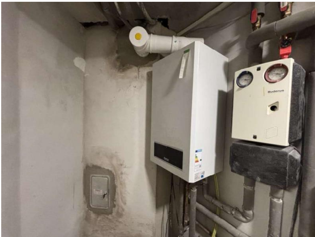
Bild 26 - Heizungsanlage, Gas-Brennwertgerät
