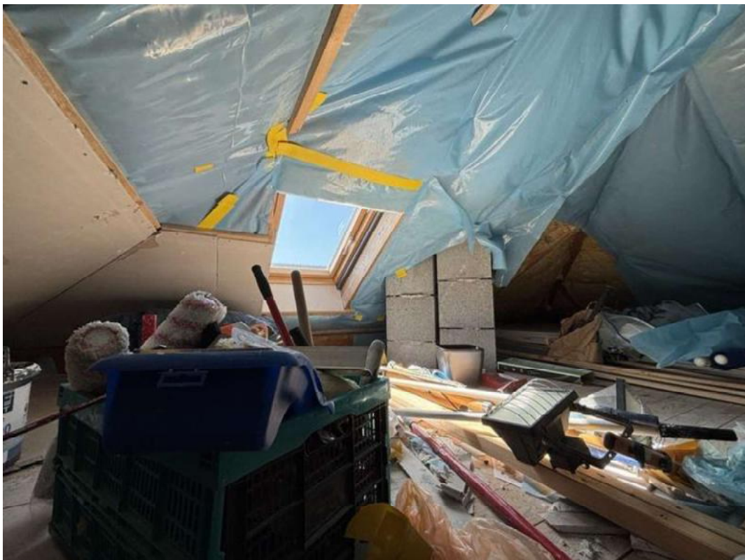
Bild 22 - Dachboden, Dachfenster, Dampfsperre, Ausbauzustand
