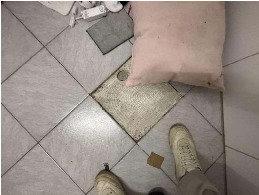
Bild 37 - Revisionsöffnung Boden, Fliesenbelag
