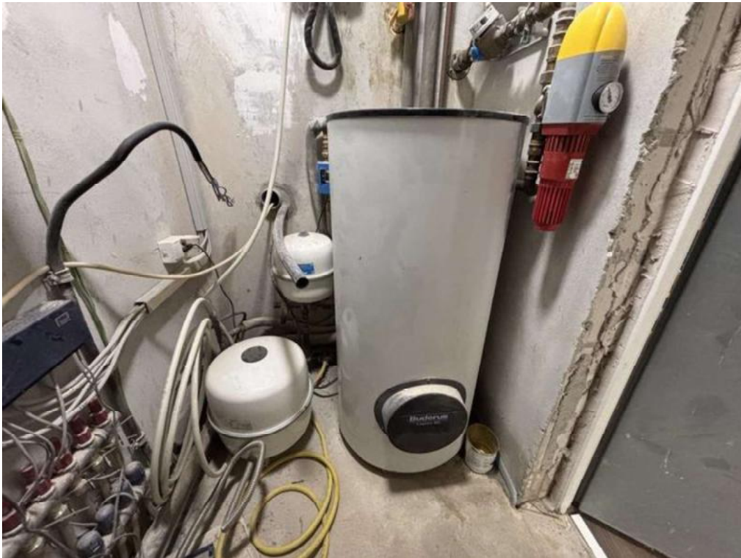
Bild 27 - Warmwasserspeicher
