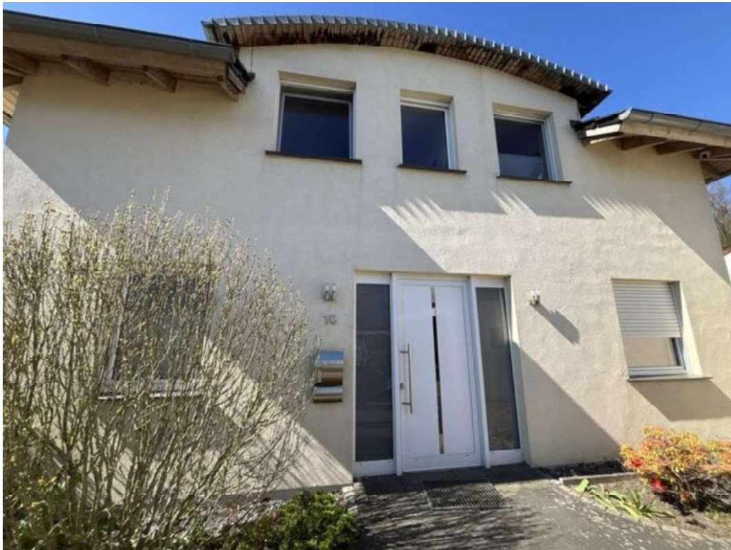
Bild 3 - Ansicht Straßenseite, Hauseingang
