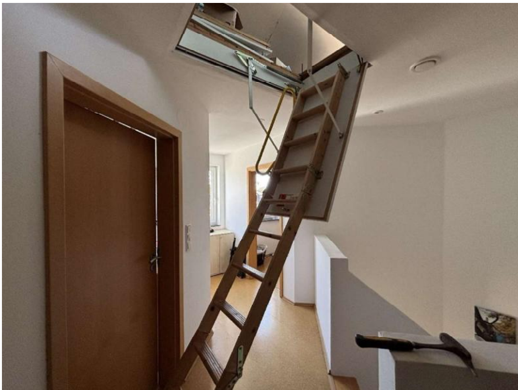
Bild 12 - Flur, Bodentreppe zum Dachboden
