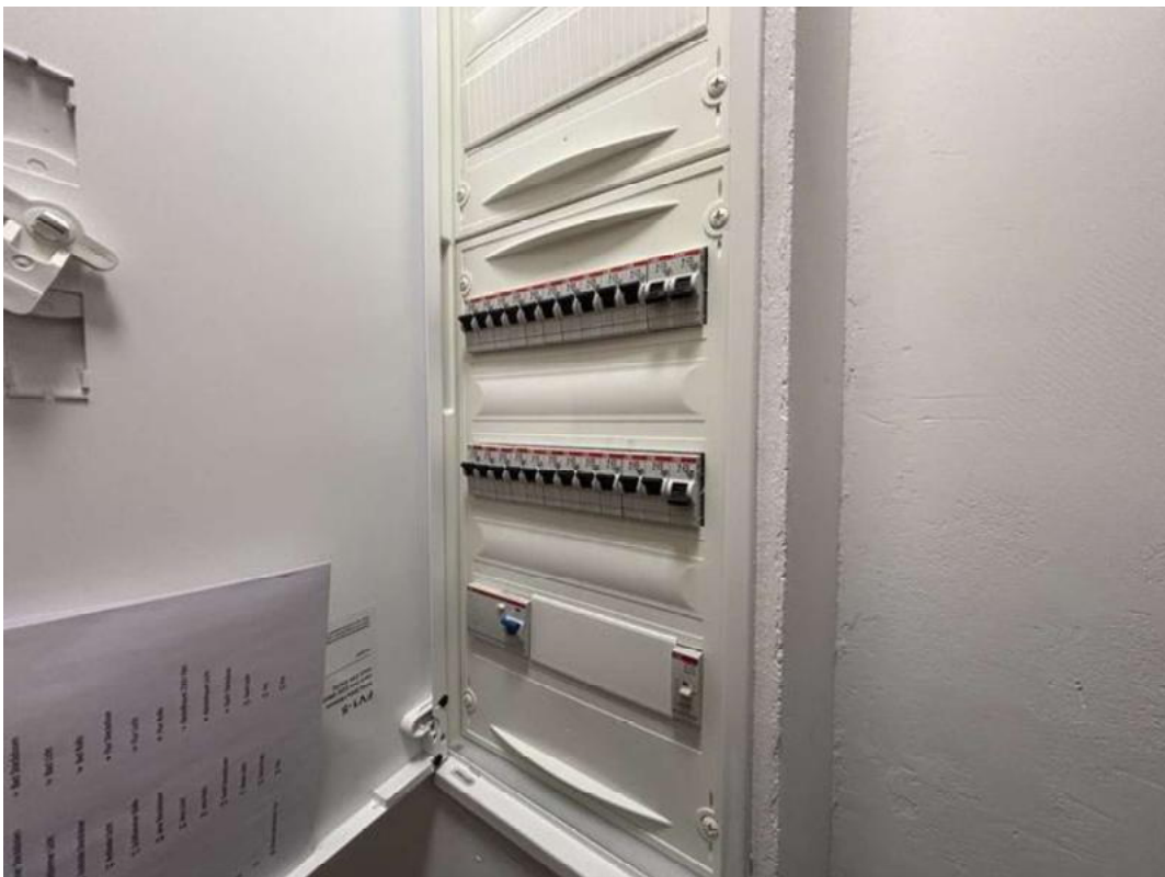
Bild 20 - Elektroverteilung, Sicherungskasten
