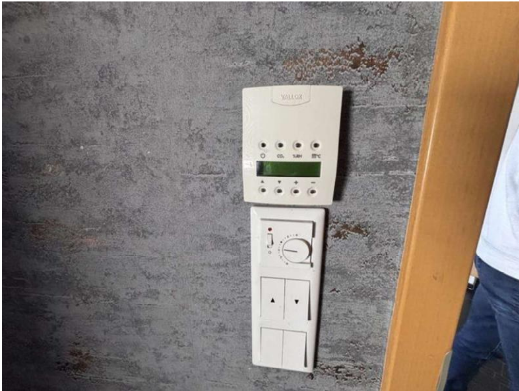
Bild 11 - Lüftungssteuerung, Raumregelung
