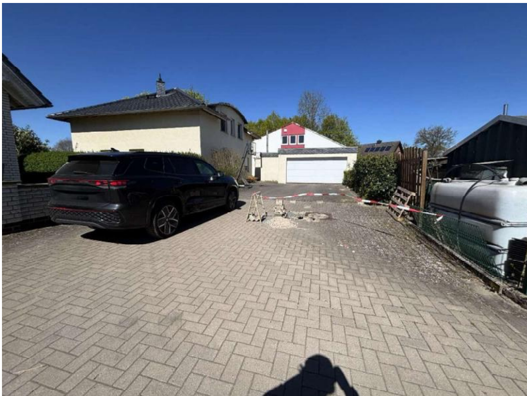
Bild 72 - Außenbereich, Hof, Aufgrabung
