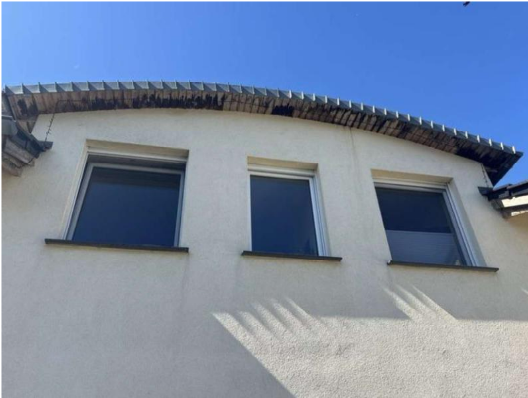
Bild 73 - Außenansicht Obergeschoss, Fensterfront, Traufe
