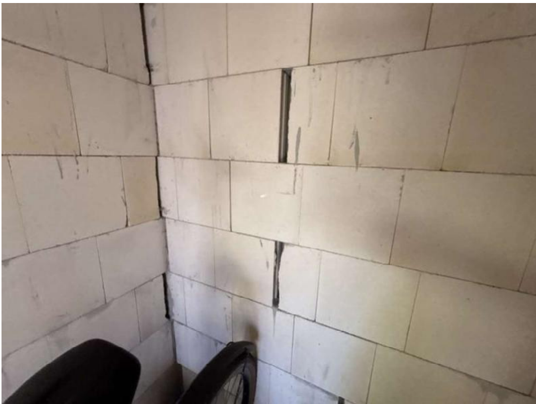
Bild 68 - Risse Mauerwerk
