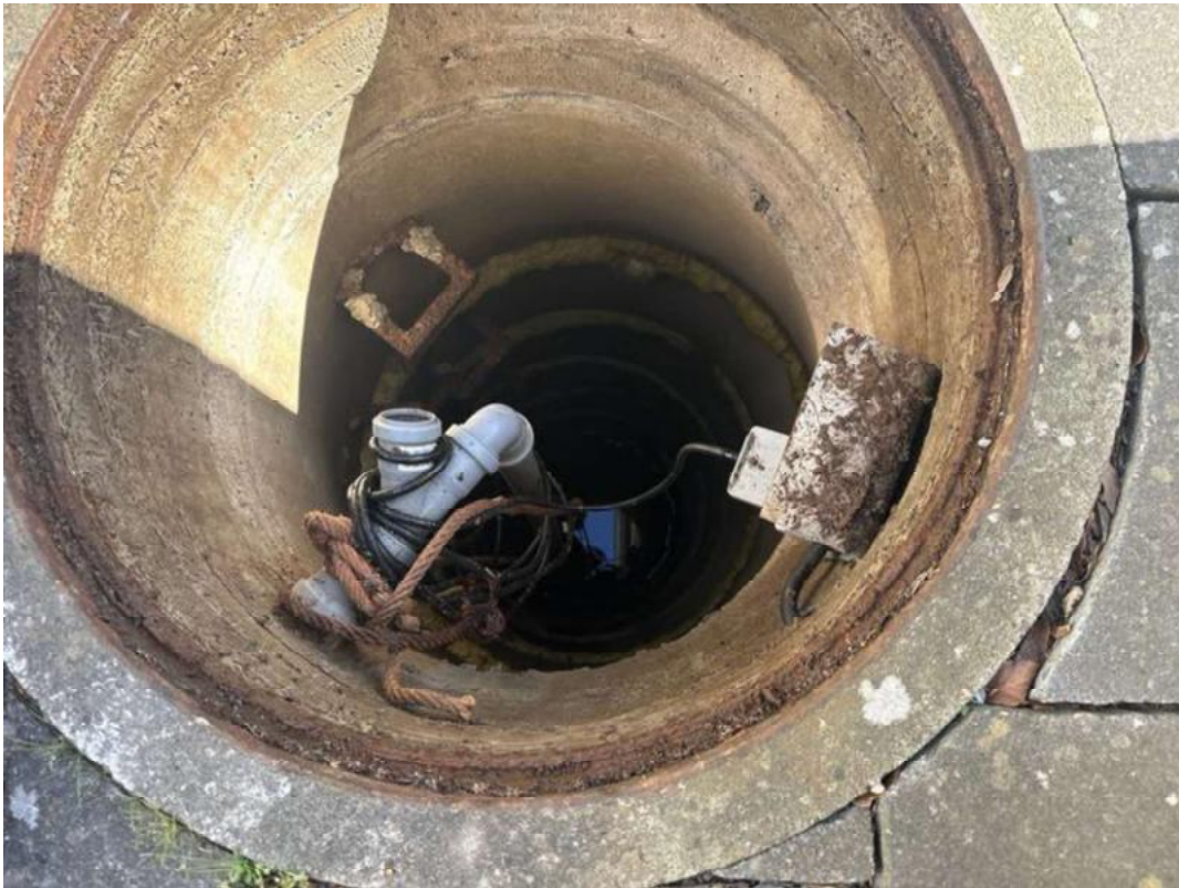
Bild 69 - Pumpenschacht
