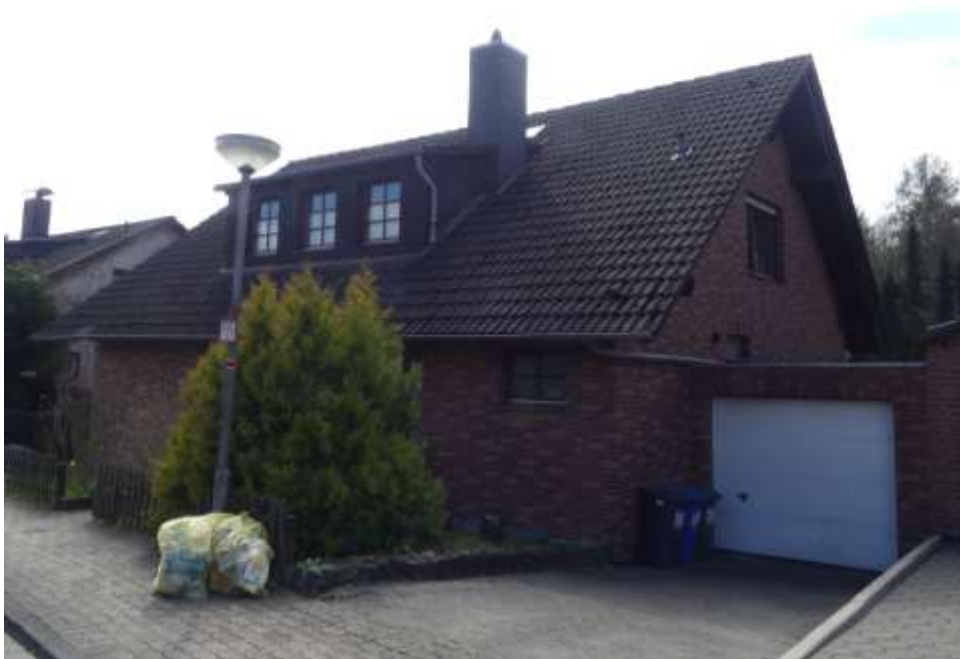
Nordansicht. Angebaute Garage mit Zufahrt
