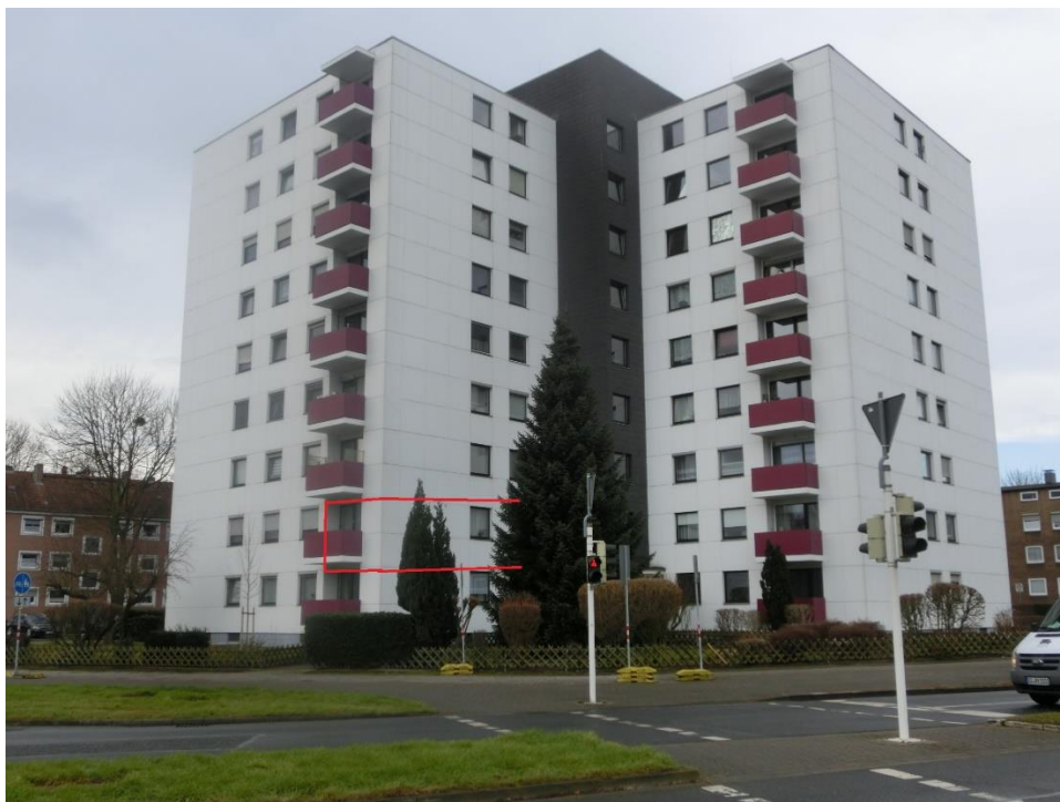
Eigentumswohnung Nr. 10, 1. OG vorn links – Ansicht von Nordosten
