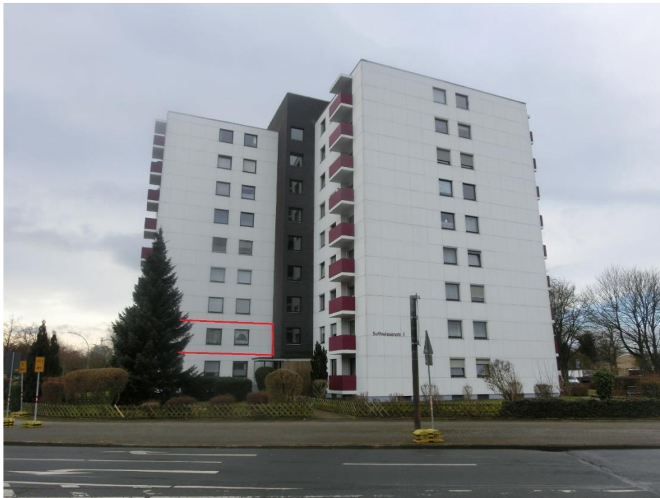
Eigentumswohnung Nr. 10, 1. OG vorn links – Ansicht von Norden
