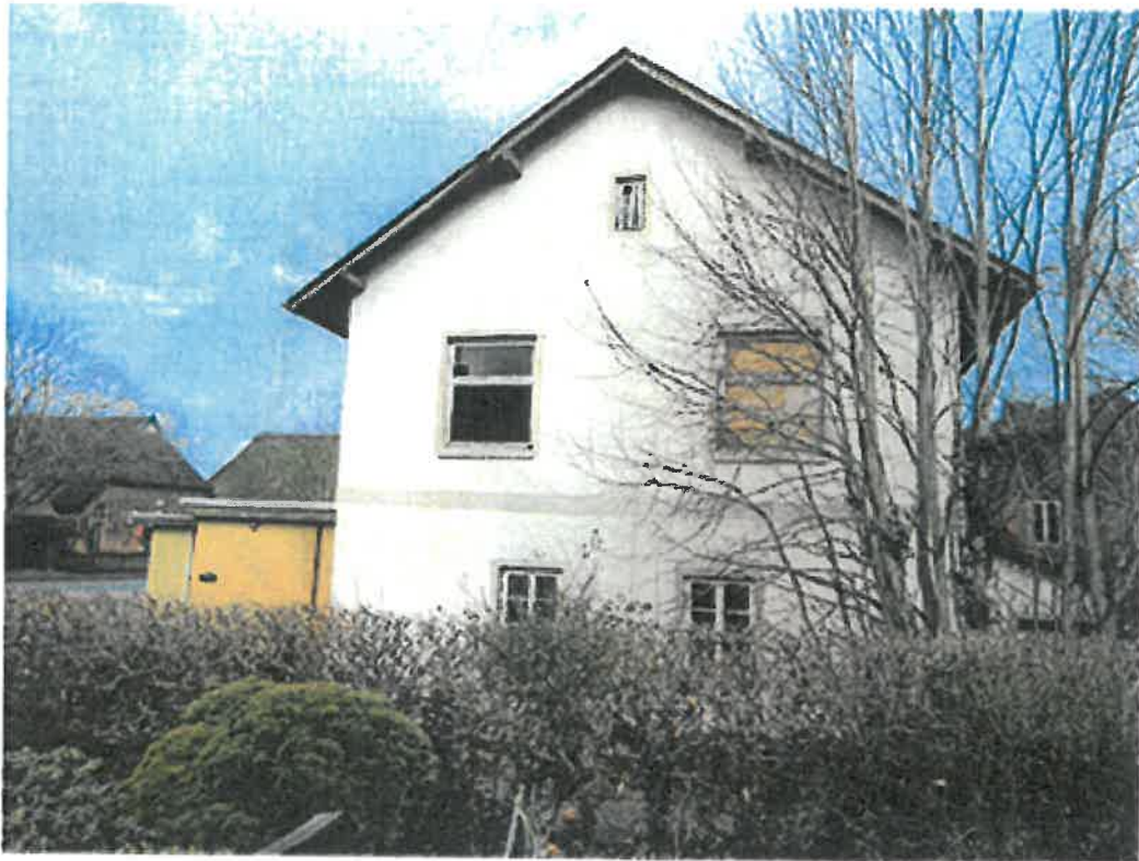
Bild oben: Wohnhaus – Südgiebel , Bild unten: Nordseite
