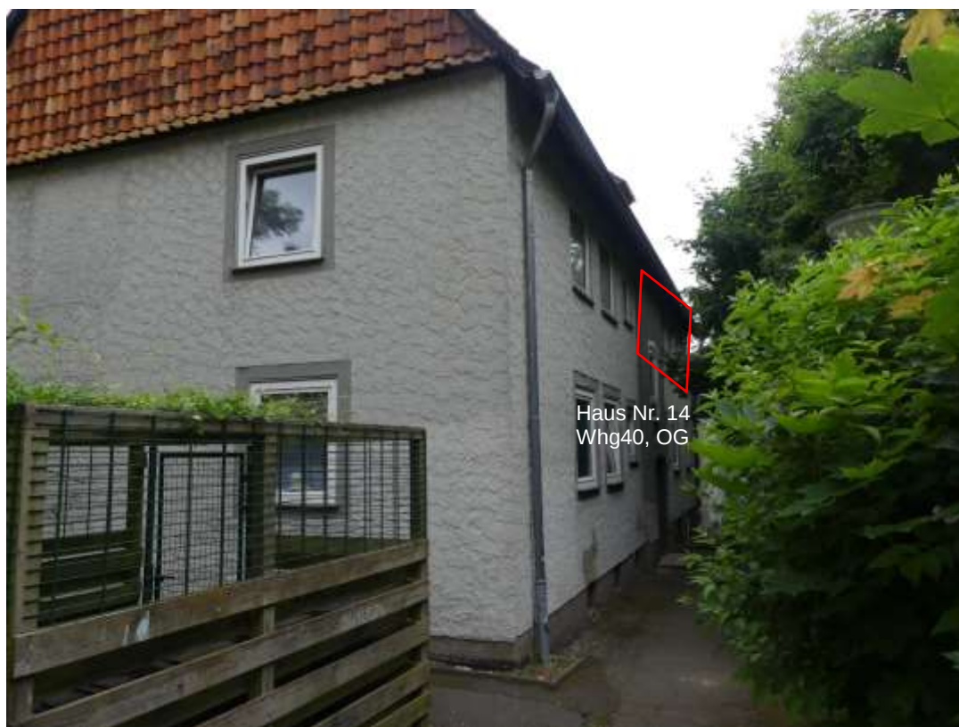
Nordwestansicht mit Hauszugang zum Gebäude Nr.14
