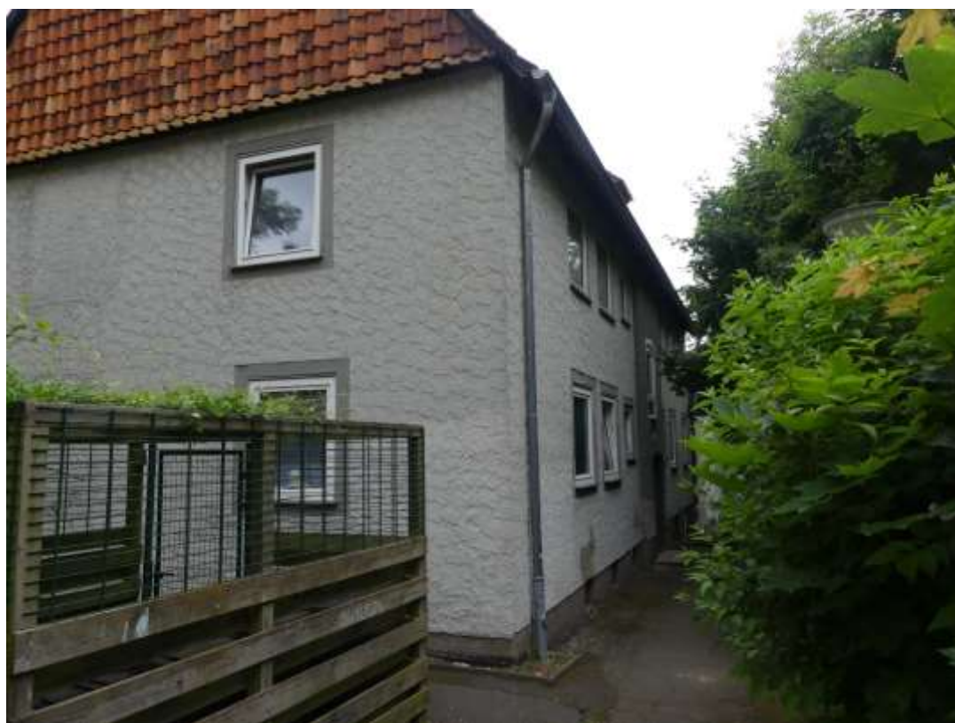
Nordwestansicht mit Hauszugang zum Gebäude Nr.14
