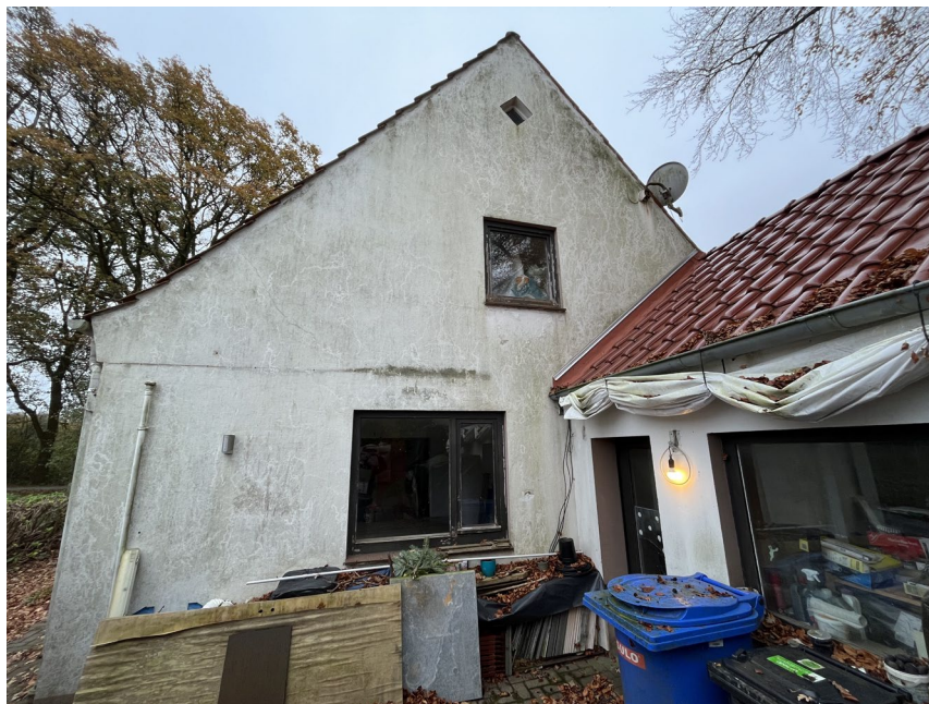
Bild 2: Rückansicht mit Anbau
