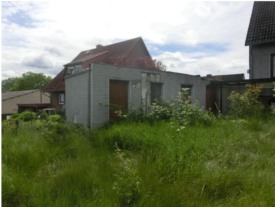
Schuppen – Ansicht von Nordwesten
