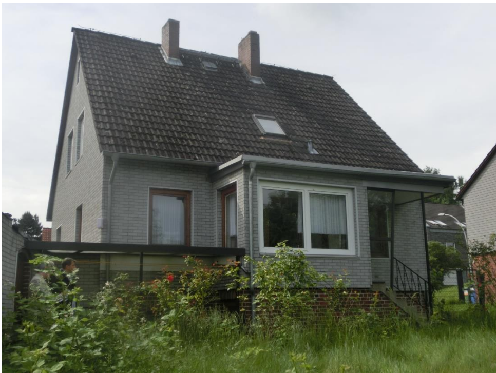
Wohnhaus – Ansicht von Westen
