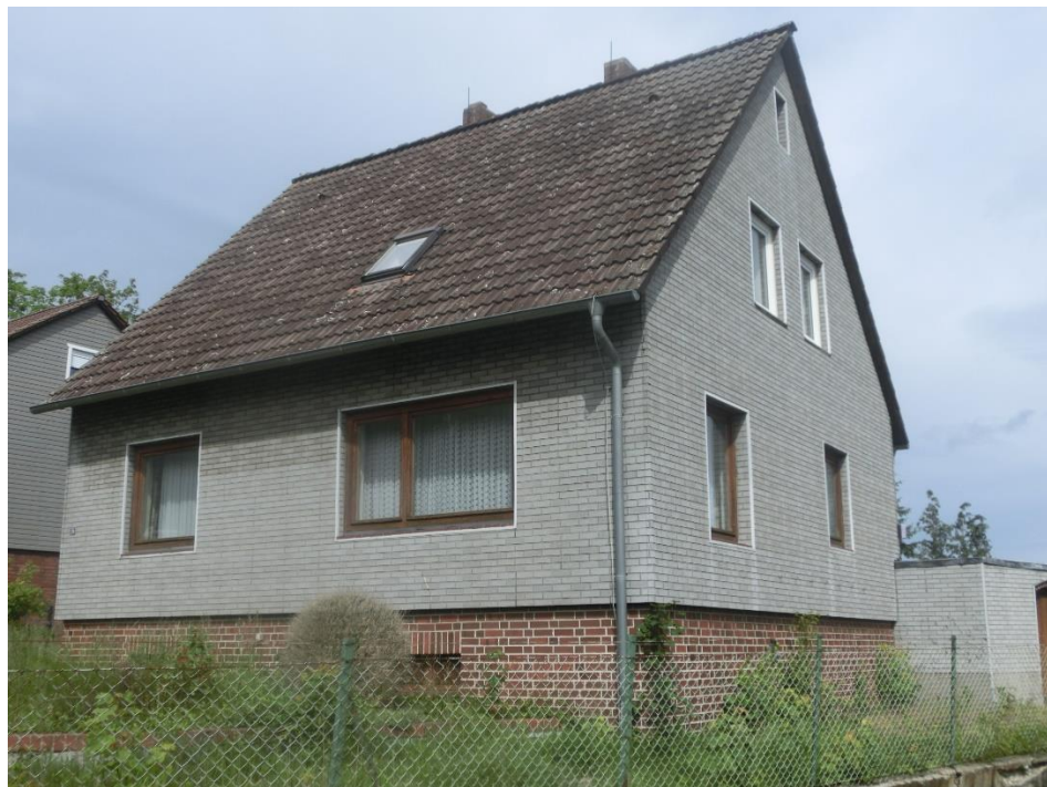
Wohnhaus – Ansicht von Südwesten
