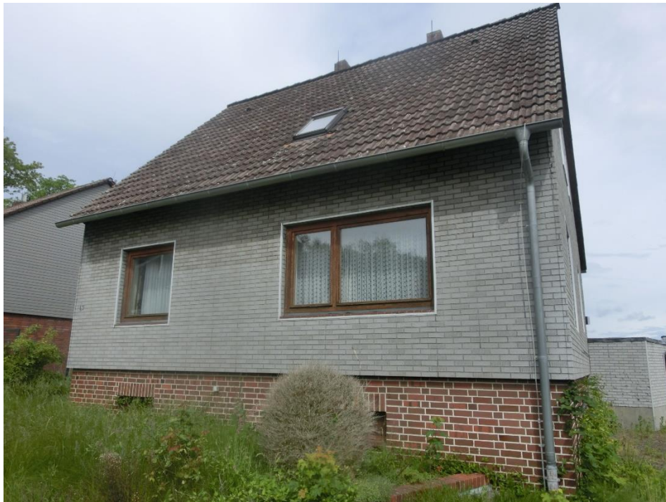
Wohnhaus – Ansicht von Südosten
