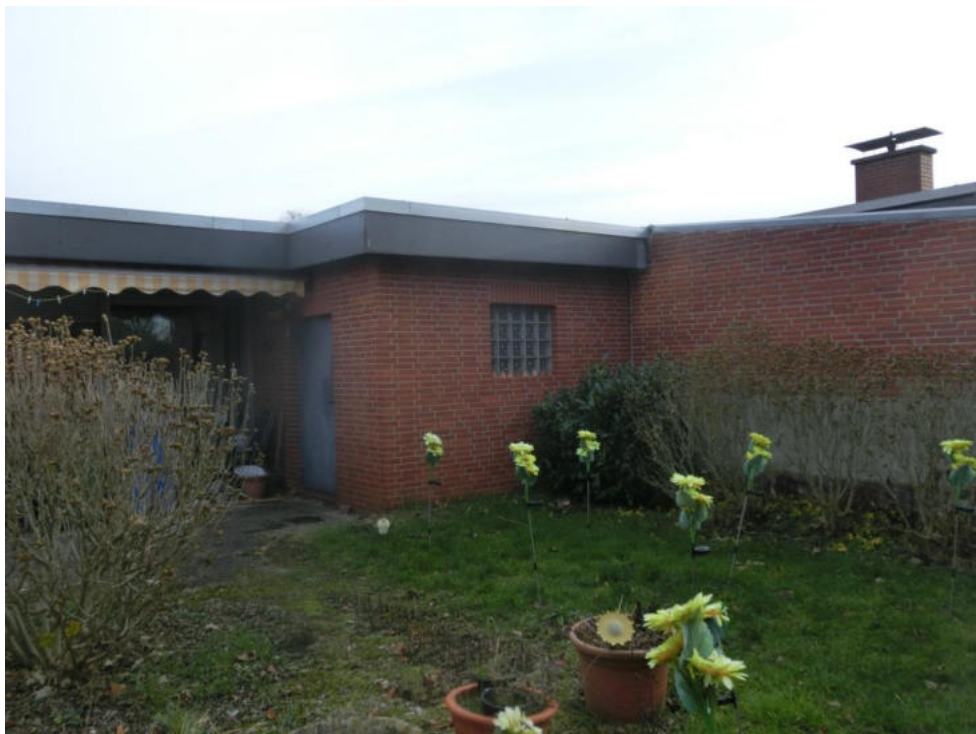
Garage – Ansicht von Westen
