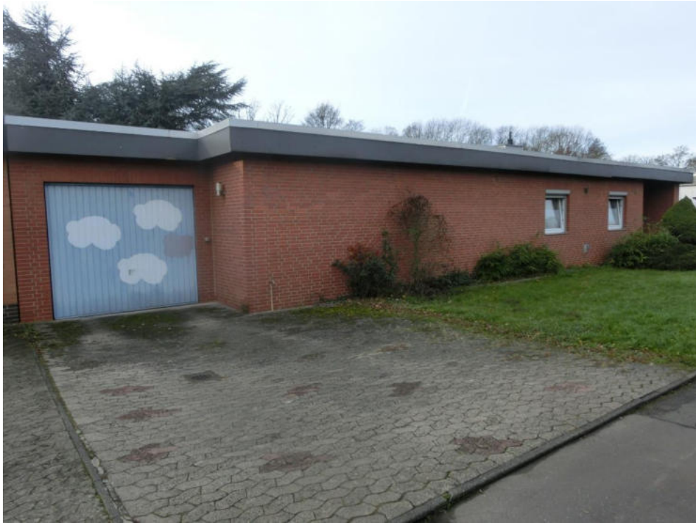
Wohnhaus – Ansicht von Osten
