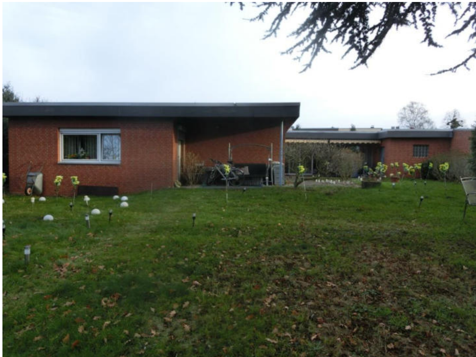
Wohnhaus, Garage – Ansicht von Südwesten
