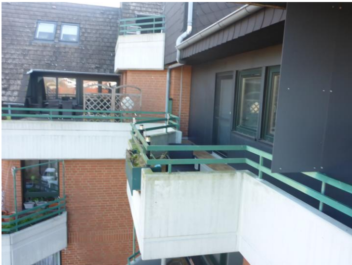
Dachbalkon der Wohneinheit 23 im 4. Obergeschoss
