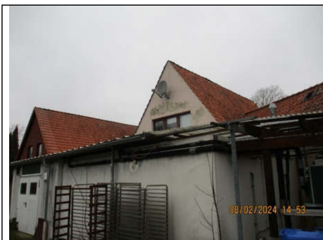
Ansicht von Südost
