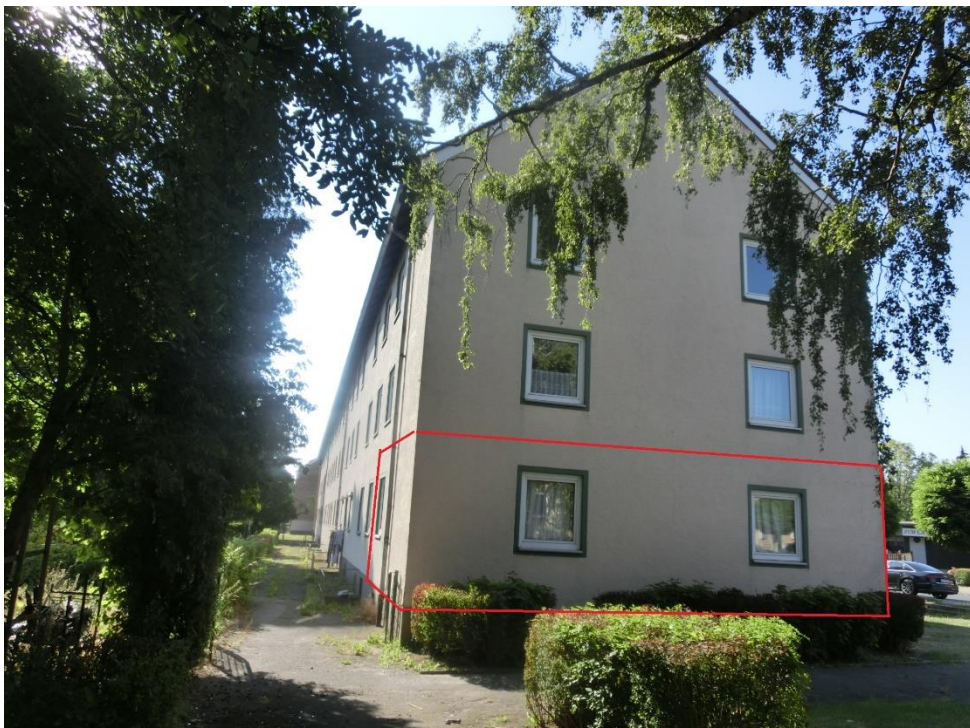
Eigentumswohnung Nr. 31, EG links – Ansicht von Nordwesten
