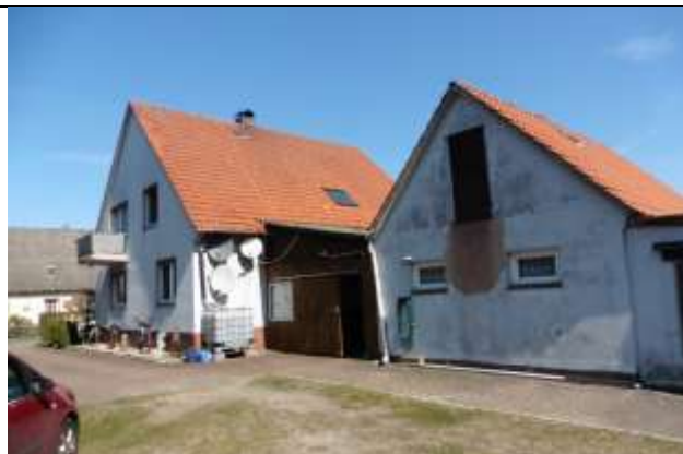
Hofansicht Wohnhaus, Zwischenbau, ehem. Stall
