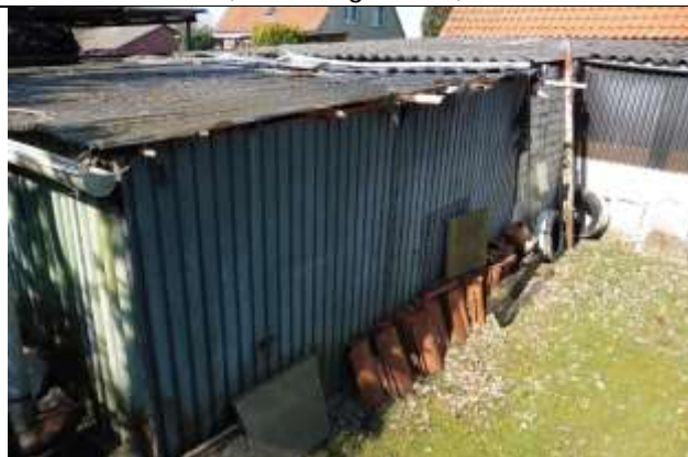
Schuppenanbau von Süden
