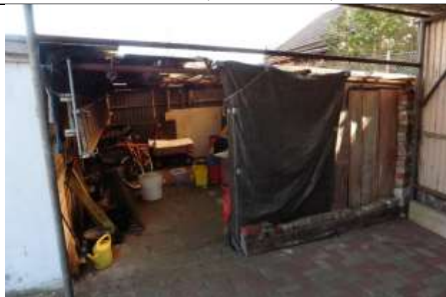
Hofansicht Schuppenanbau an Stallanbau
