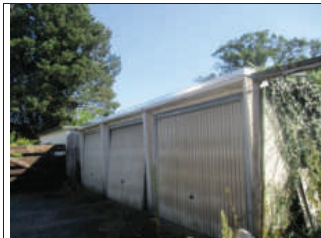
Ansicht von Nordwest
