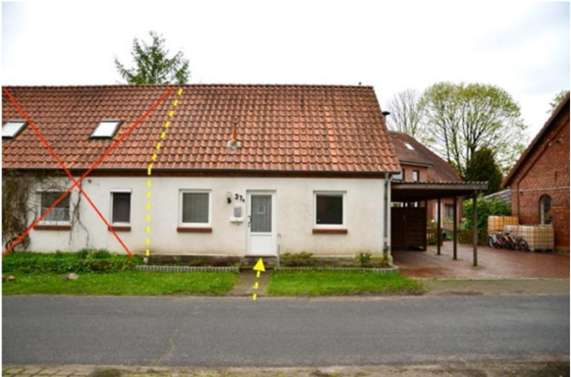
Foto 1 Straßenansicht von Nordosten: ungefähre Lage der gegenständlichen Wohnung Nr. 2 im Erdgeschoss nebst Bodenraum im Dachgeschoss der Doppelhaushälfte Dieker Str. 37 B ist nachträglich gelb markiert
