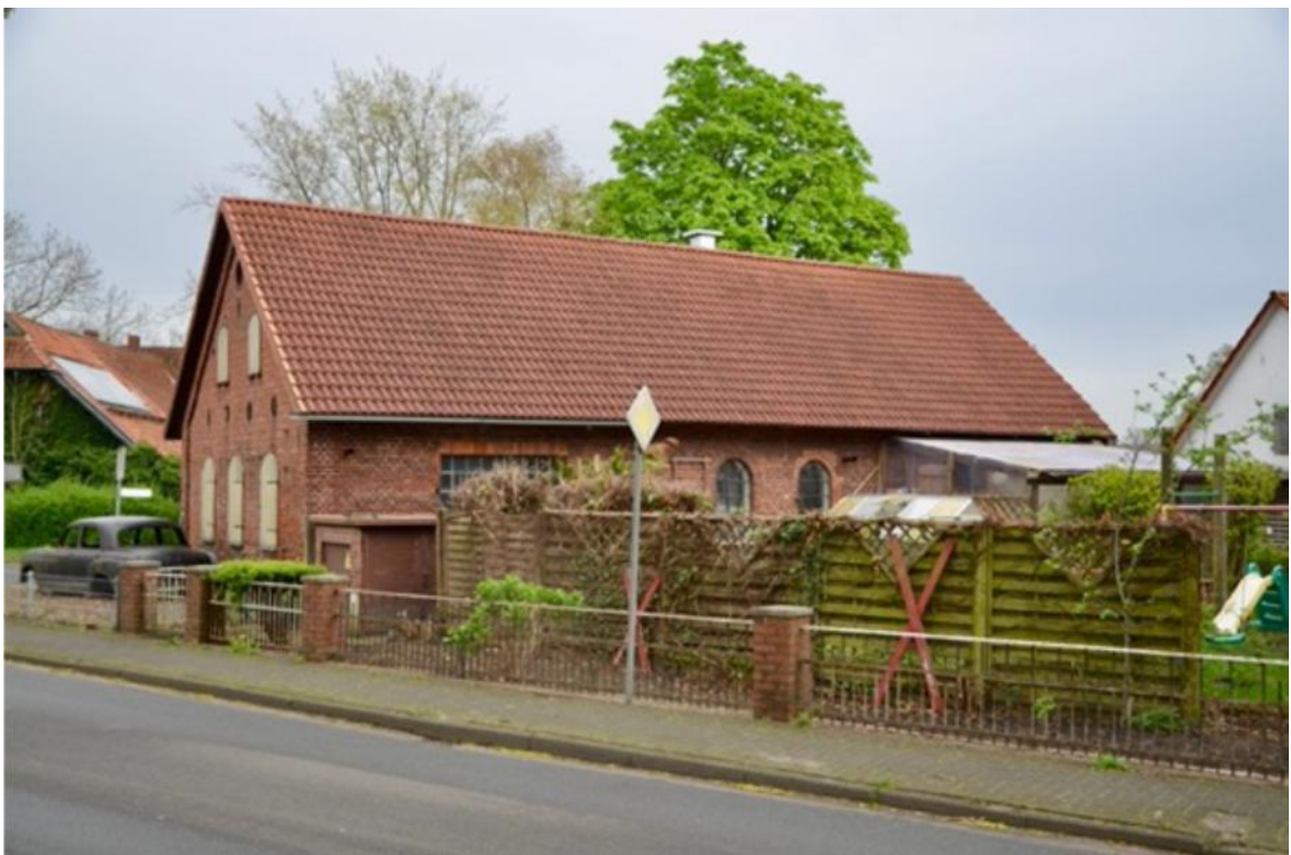
Foto 4 Ansicht von Südwesten: Ehem. Schmiede (Teileigentum Nr. 3) als Teil der Mehrhausanlage
