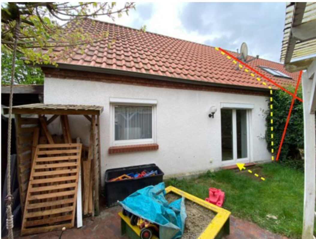
Foto 2 Ansicht von Südwesten: ungefähre Lage der gegenständlichen Wohnung Nr. 2 im Erdgeschoss nebst Bodenraum im Dachgeschoss der Doppelhaushälfte Dieker Str. 37 B ist nachträglich gelb markiert
