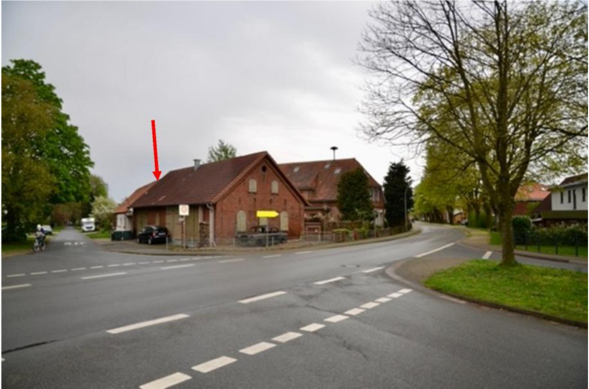
Foto 9 Blick von Wilstedter Str. Ecke Hauptstraße in Richtung Südosten auf die vollständige Mehrhausanlage, Doppelhaushälfte nachträglich mit rotem Pfeil markiert
