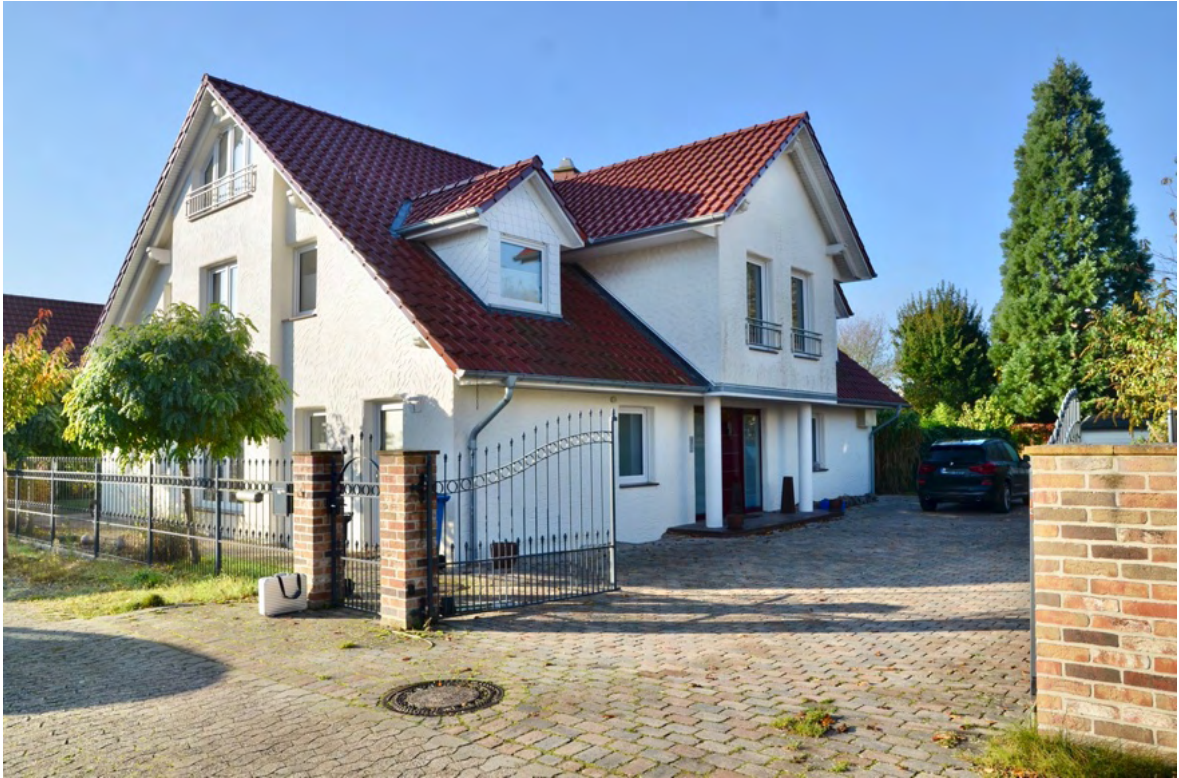
Foto 1 Straßenansicht von Nordosten
