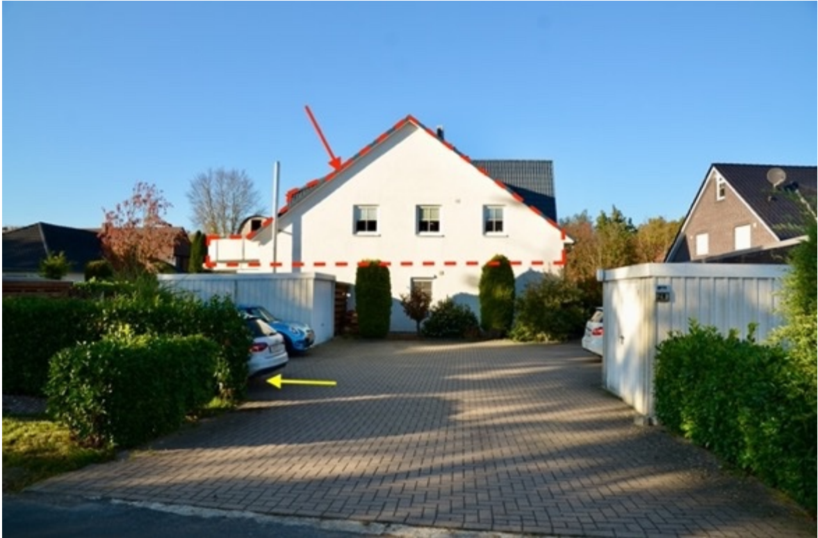
Foto 1 Straßenansicht des Vierfamilienhausgrundstücks von Süden; ungefähre Lage der gegenständlichen Eigentumswohnung mit Balkon ist rot markiert, des Pkw-Stellplatzes gelb
