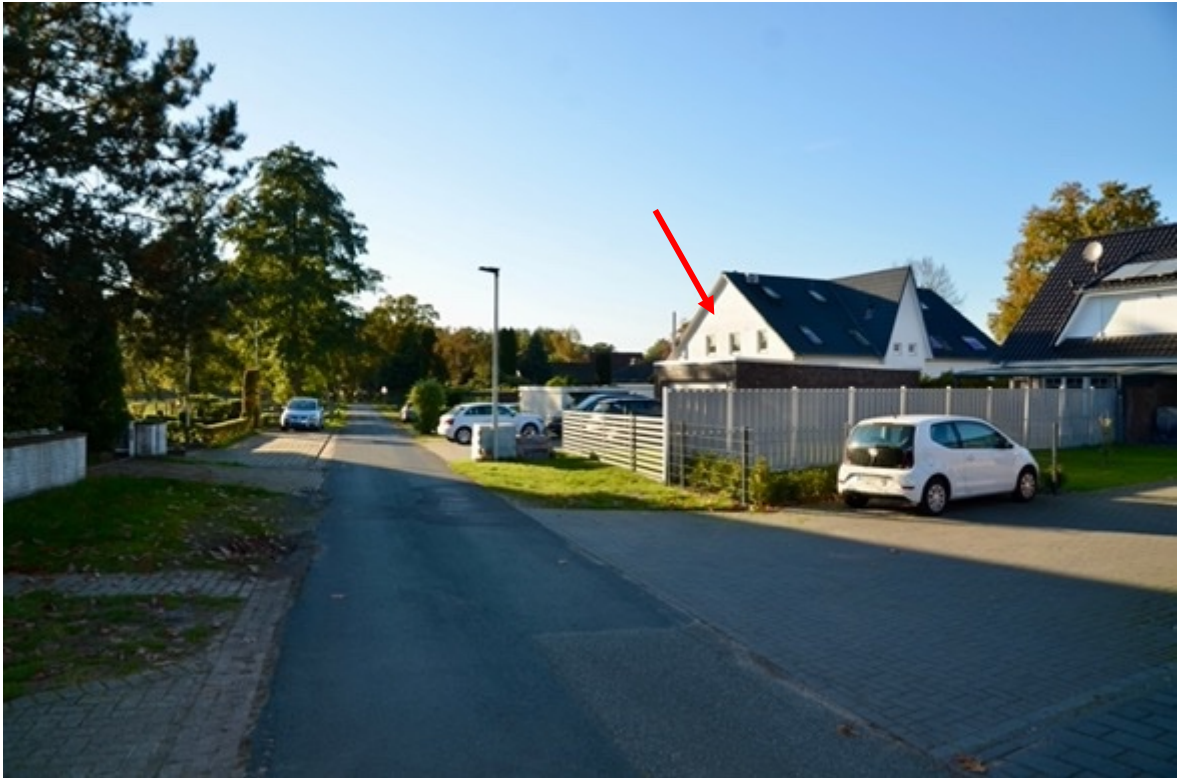
Foto 11 Blick von Brunnenweg in Richtung Westen, ungefähre Lage der Wohnung ist nachträglich mit rotem Pfeil markiert
