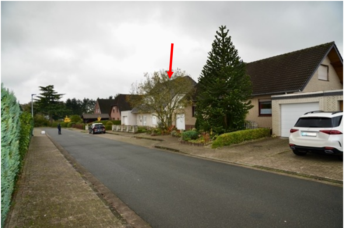
Foto 5 Hoher Acker, Blick nach Süden, Einfamilienhaus mit rotem Pfeil markiert
