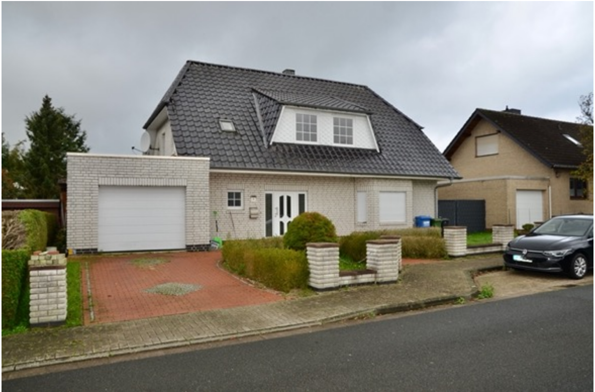
Foto 1 Ansicht von Osten: Einfamilienhaus -Pos. 1- mit Garage -Pos. 2-
