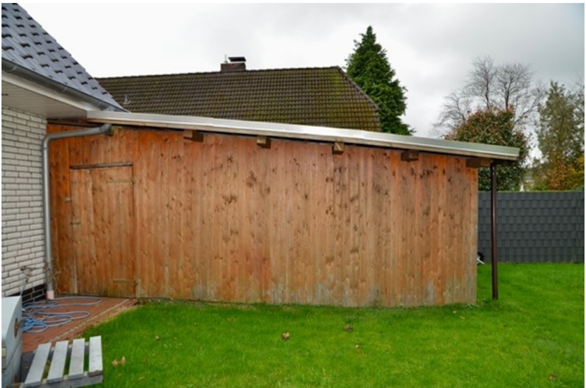
Foto 4 Ansicht von Nordwesten: Gartengerätehaus -Pos. 3-, links EFH -Pos. 1-
