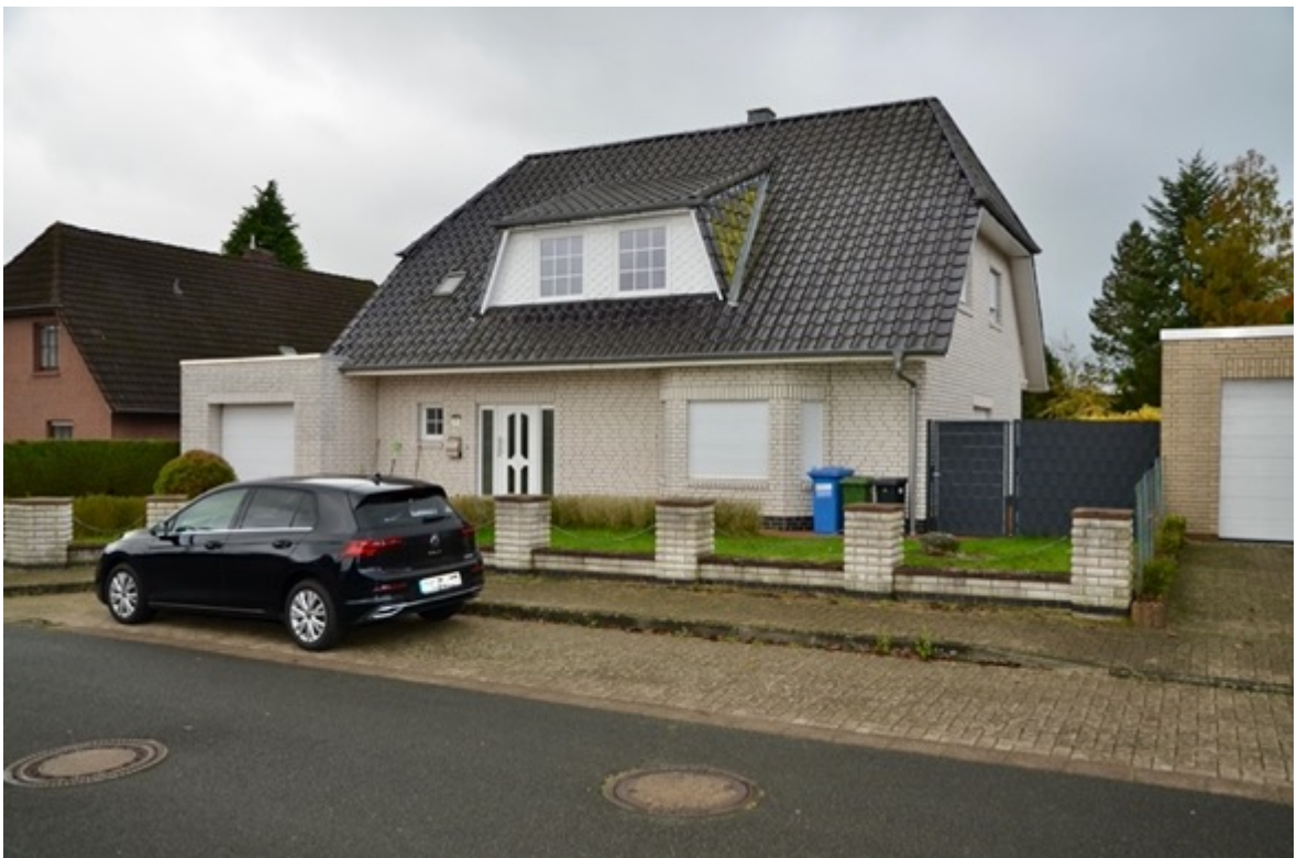
Foto 2 Ansicht von Nordosten: Mitte Einfamilienhaus -Pos. 1-, links Garage -Pos. 2-
