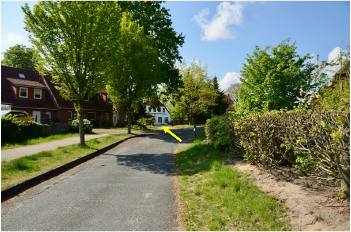
Foto 18 Blick von Am Sandberg in Richtung Nordwesten, Objekt nachträglich gelb markiert
