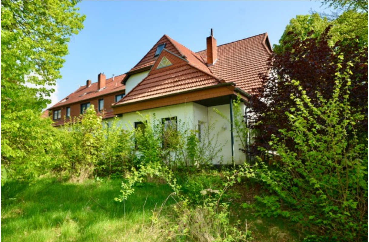
Foto 3 Ansicht Mehrfamilienhaus von Nordwesten
