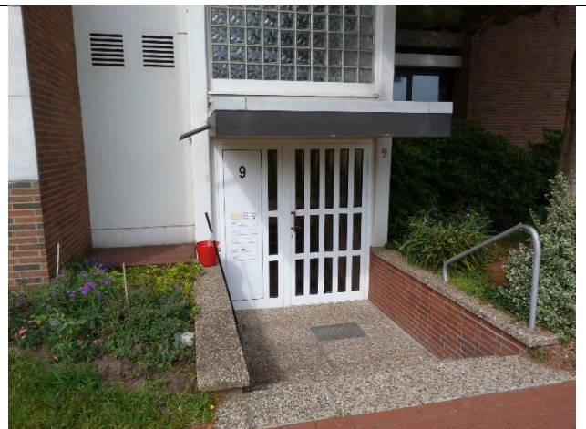
Ansicht des Eingangsbereiches Nr. 9
