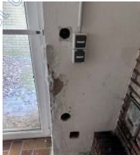
Bild 36: Feuchtigkeitsschaden im Bereich des Kamins im KG
