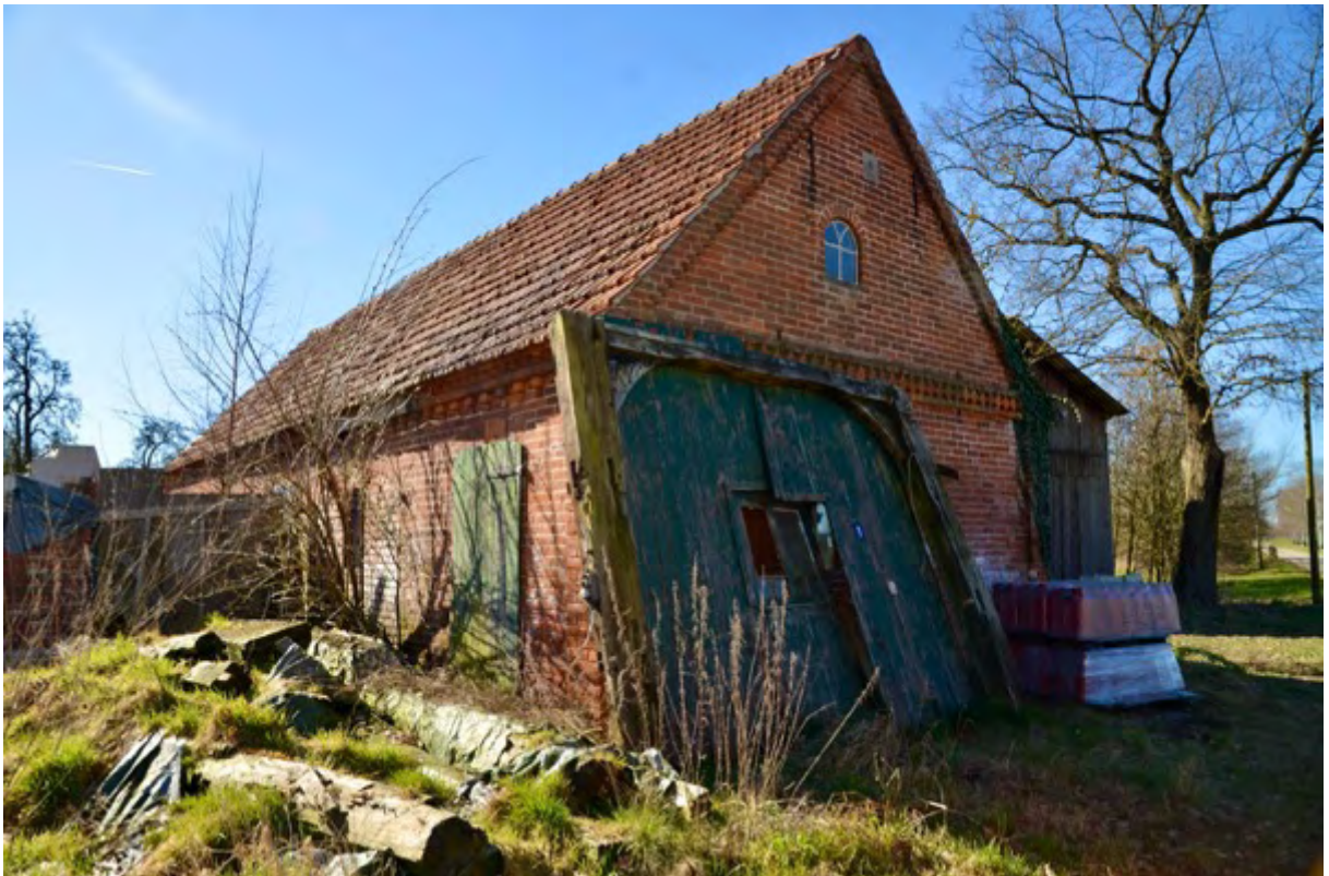
Foto 4 Ansicht des ehemaligen Stallgebäudes (Pos. 2) von Nordosten
