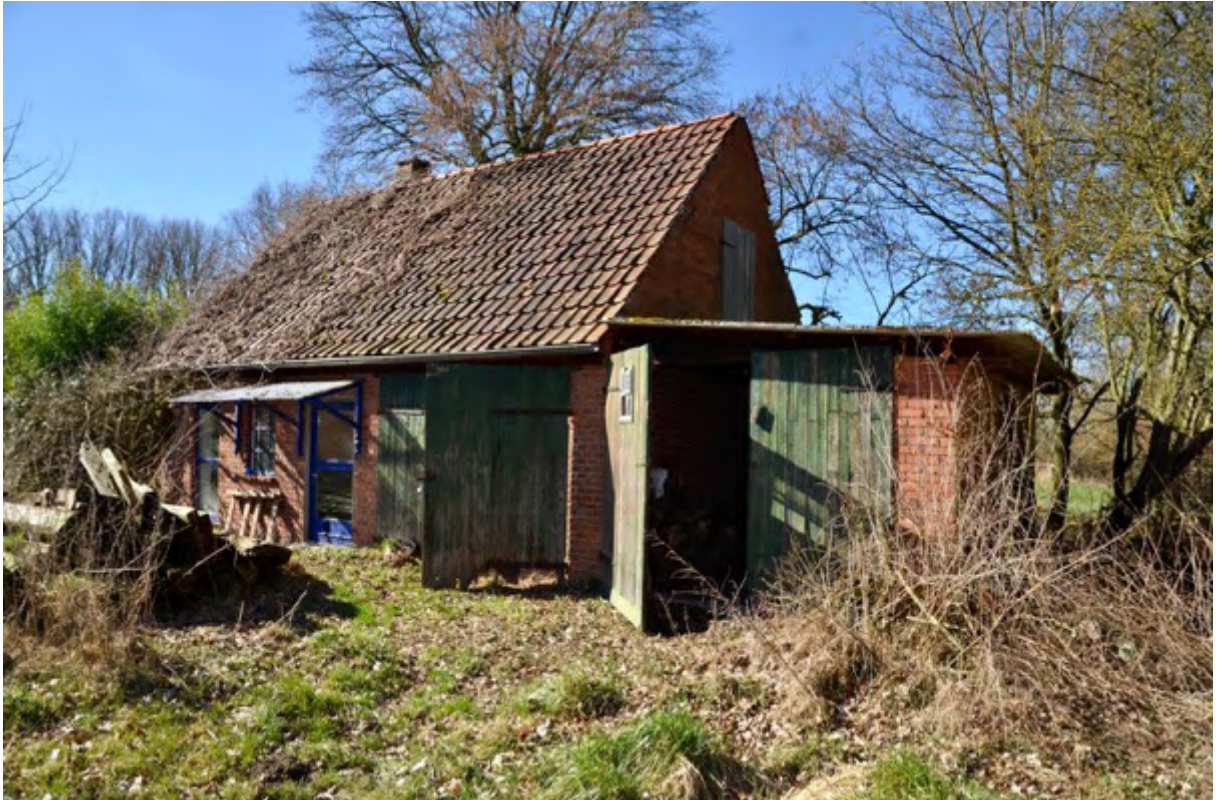
Foto 17 Ansicht des ehemaligen Hühnerstalls mit Garage von Nordosten, rechts später angebaute Treckergarage (Pos. 4)
