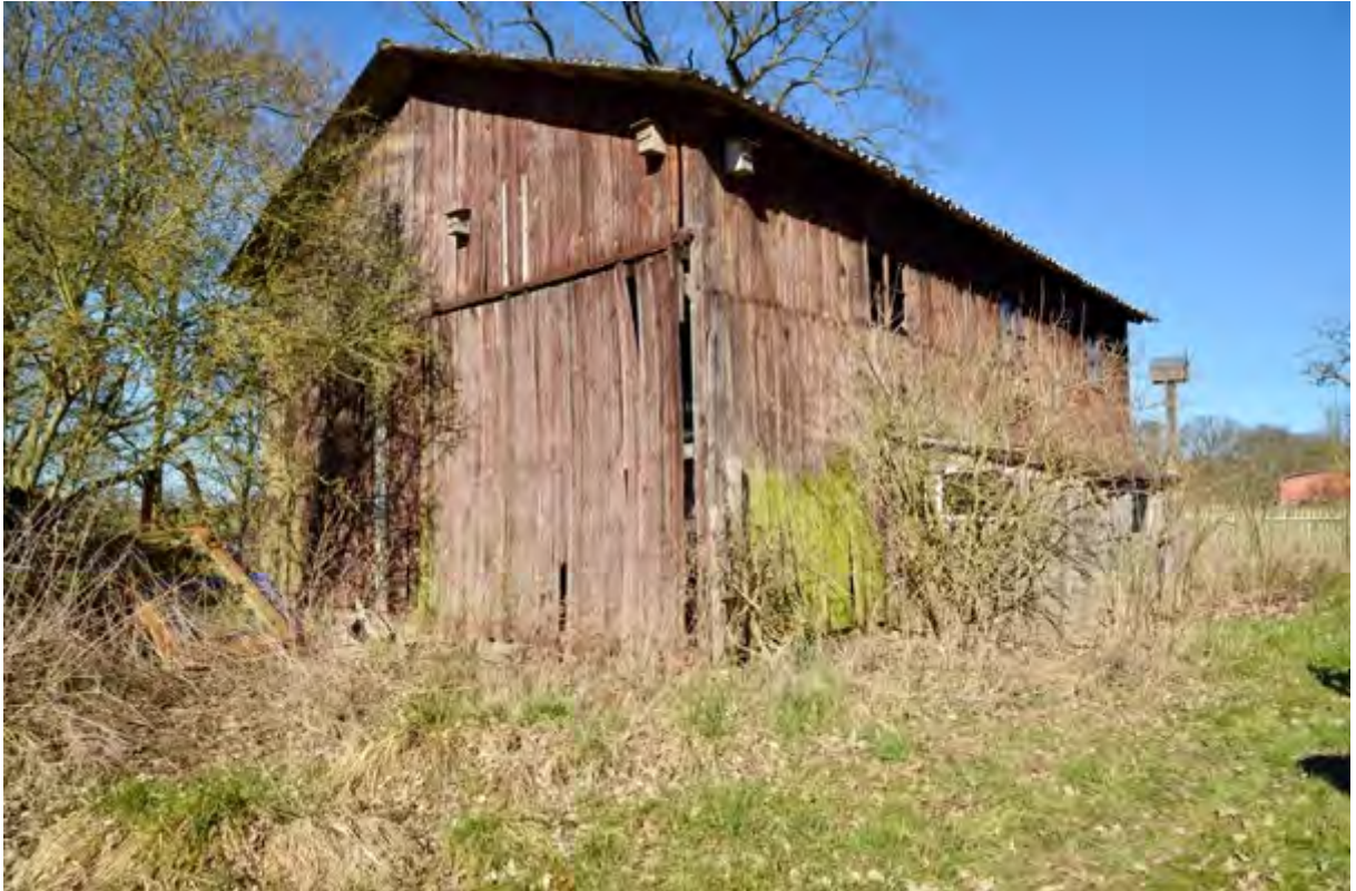
Foto 15 Ansicht der ehemaligen Kornscheune (Pos. 3) von Südosten
