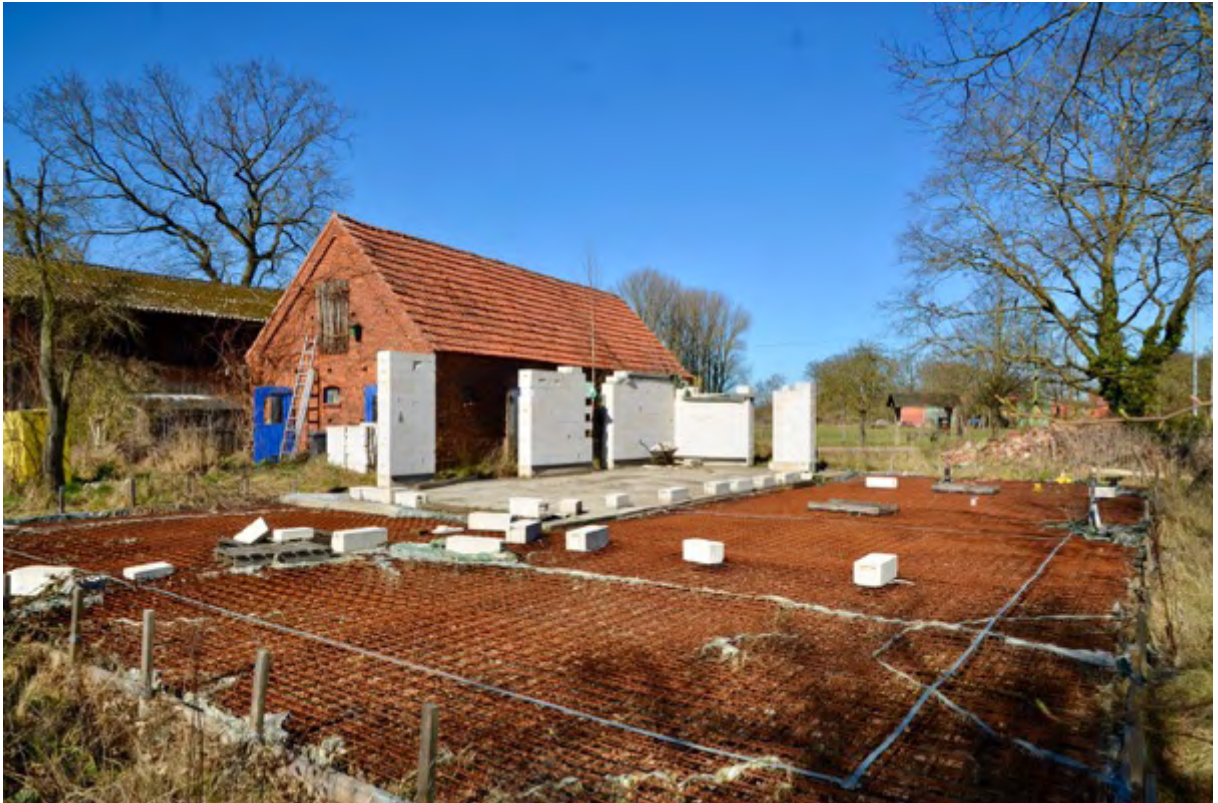
Foto 3 Blick auf begonnene Arbeiten an der Stelle des früheren Wohn- und Wirtschaftsgebäudes (Pos. 1), dahinter ehemaliges Stallgebäude (Pos. 2), linker Bildrand ehemalige Kornscheune (Pos. 3)
