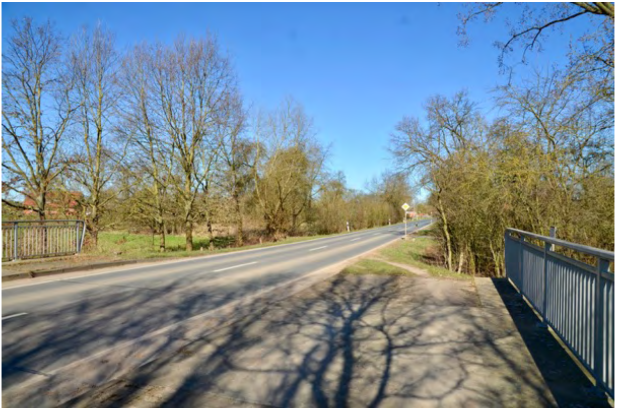
Foto 30 Blick von Oister Dorfstraße (am südlichen Ortseingang von Oiste am Schöpfwerkgraben) in Richtung Nordnordwesten
