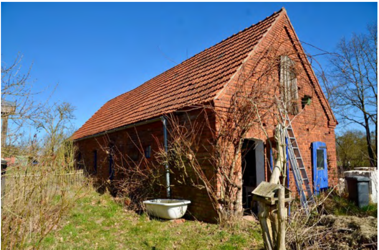
Foto 6 Ansicht des ehemaligen Stallgebäudes (Pos. 2) von Südwesten
