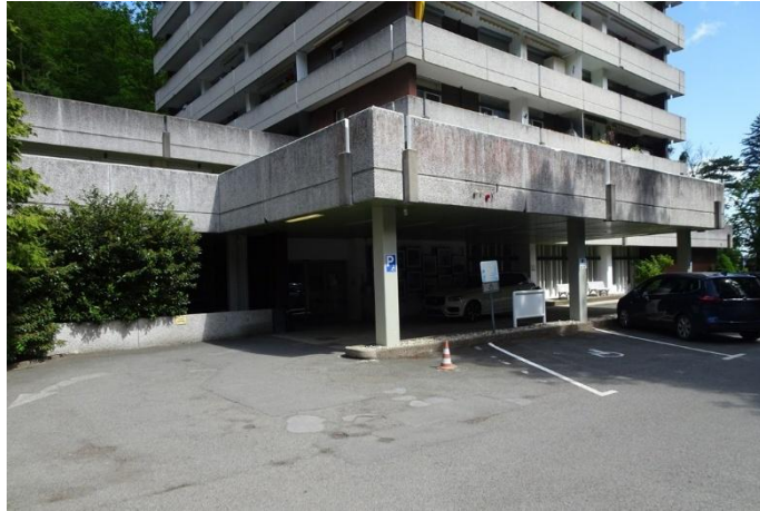
Haupteingang zum Objekt
