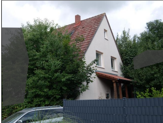
Ansicht von Süd-Ost
