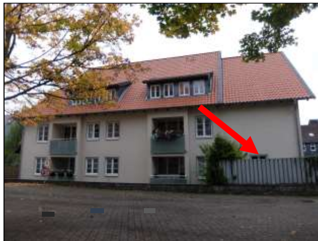
Ansicht von Süd-West
