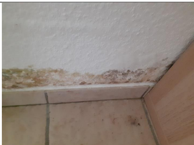
aufsteigende Feuchtigkeit
