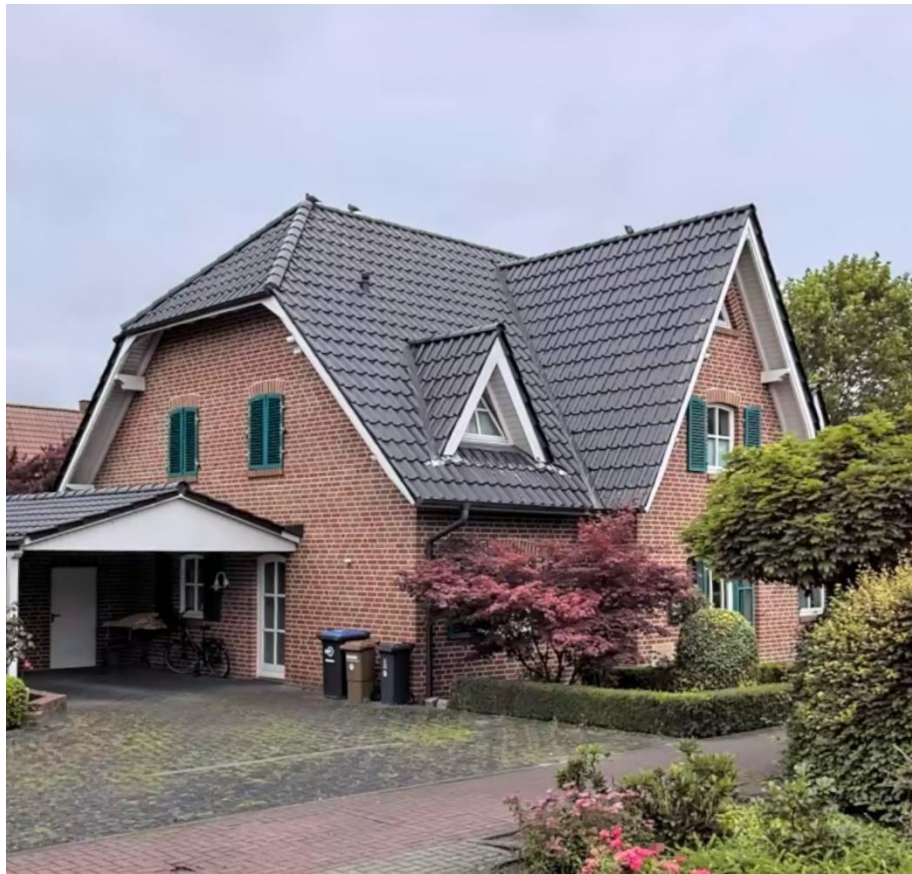
Objekt: Emsbüren, Lindenweg 16
