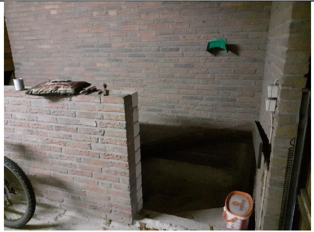
Zugang zum Keller unter Wohnhaus
