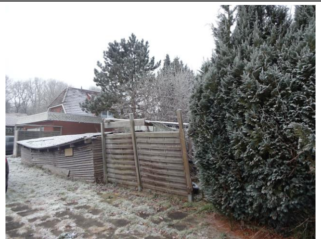
Schuppen von der Straße
