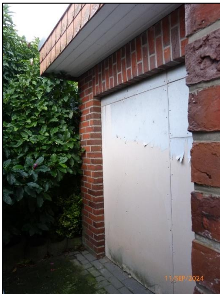
Ansicht Garage Nr. 1
