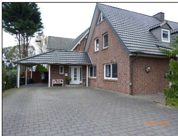
südliche Ansicht – Eingangsbereich / Anbau an bestehendes Wohnhaus
