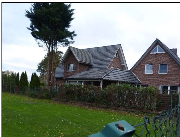
südwestliche Ansicht - Wohnhaus
