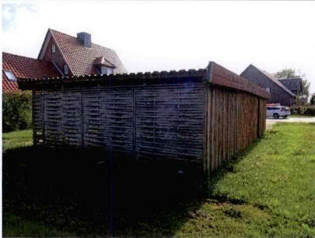
Ansicht der Garage (Rückseite)
